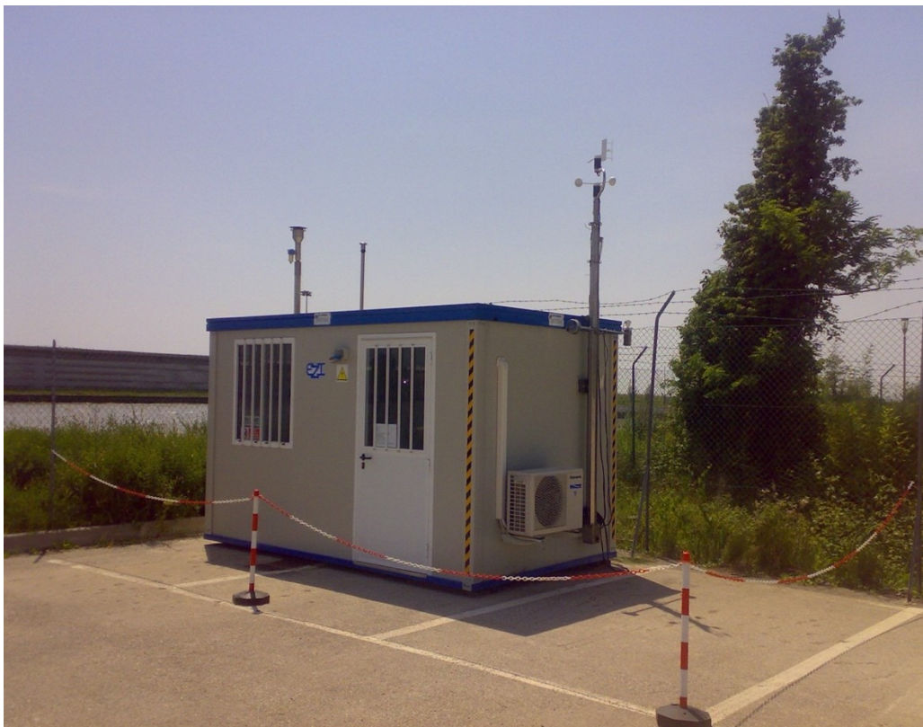
Figura 10 – Fotografia della centralina per il rilievo dei dati di inquinamento presso l'Aeroporto di Venezia.
