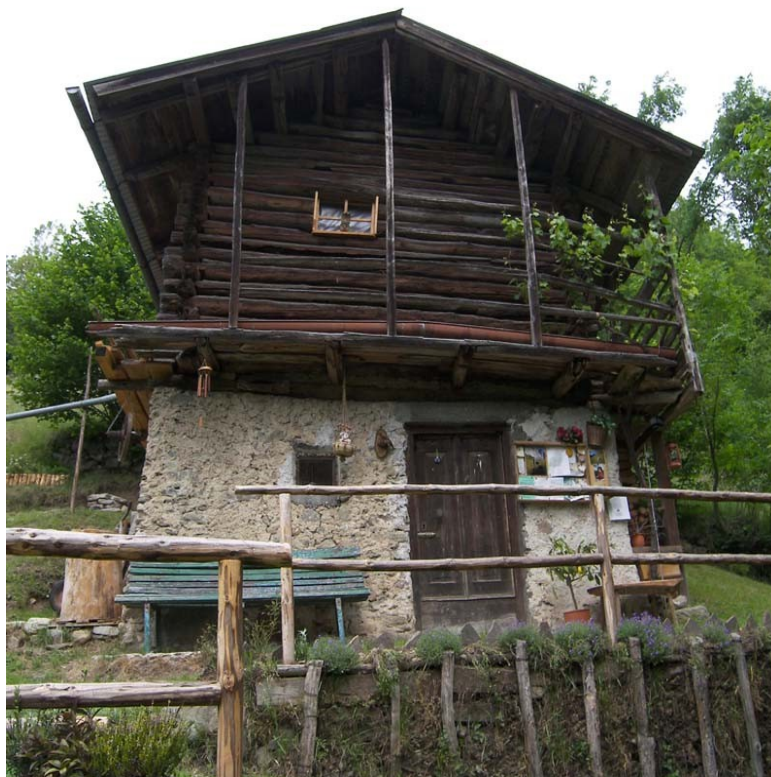
IME02024: stalla in muratura sormontata dal fienile.
