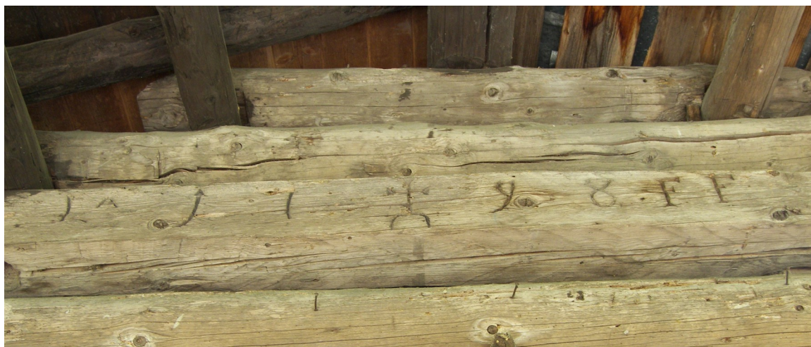
SIRO202001: vecchio architrave, riutilizzato come trave dell'incastellatura del timpano.
