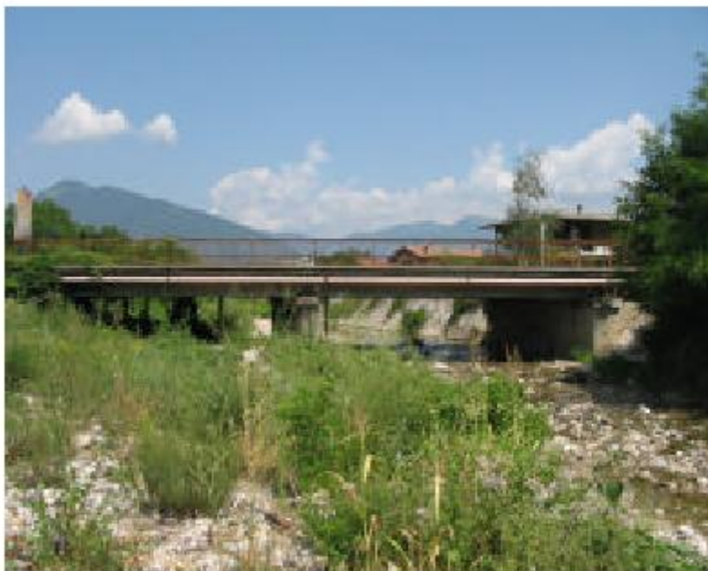
Foto del ponte 4 – Vi.abilità
