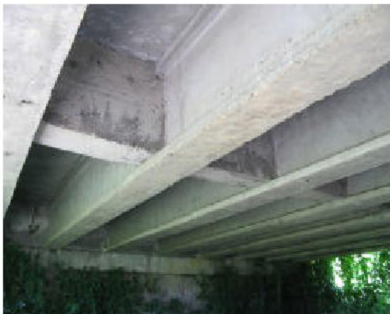
Foto del ponte 5 – Vi.abilità
