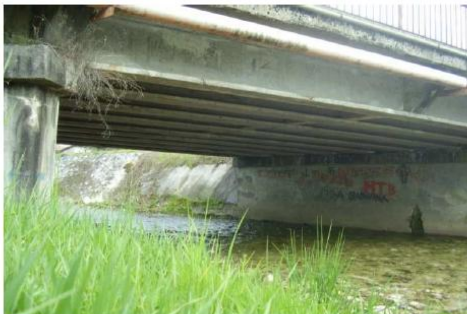
Foto del ponte 2 - Vi.abilità
