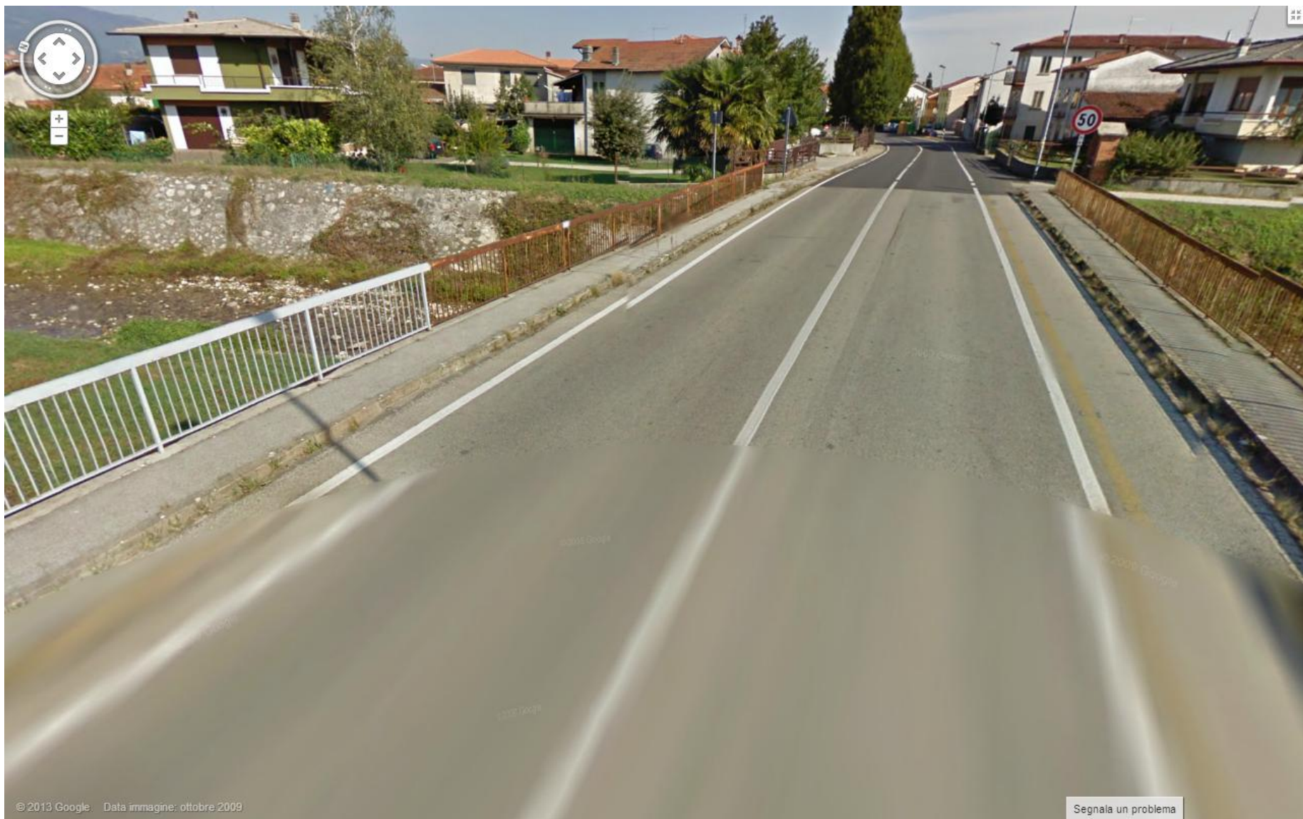
Foto ponte di Marano Vicentino SPX - Google Maps
