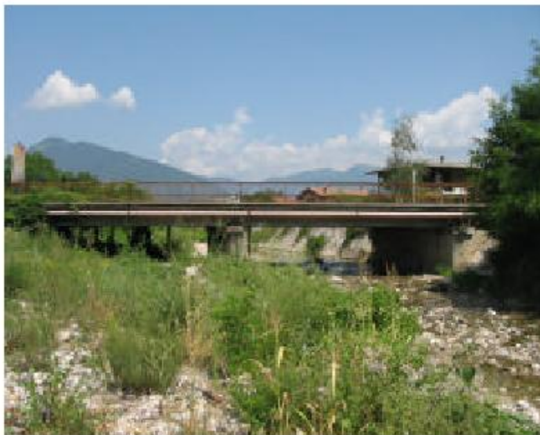
Foto del ponte 4 óVi.abilità
