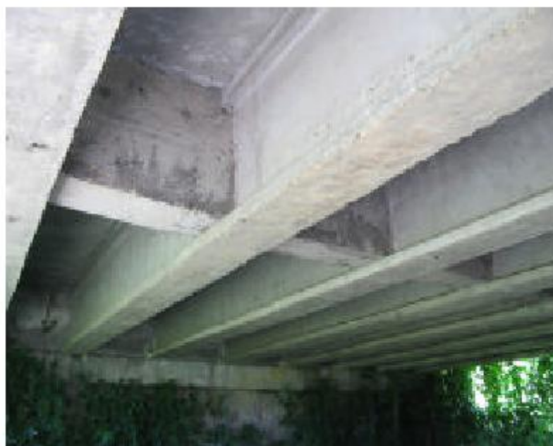
Foto del ponte 5 óVi.abilità
