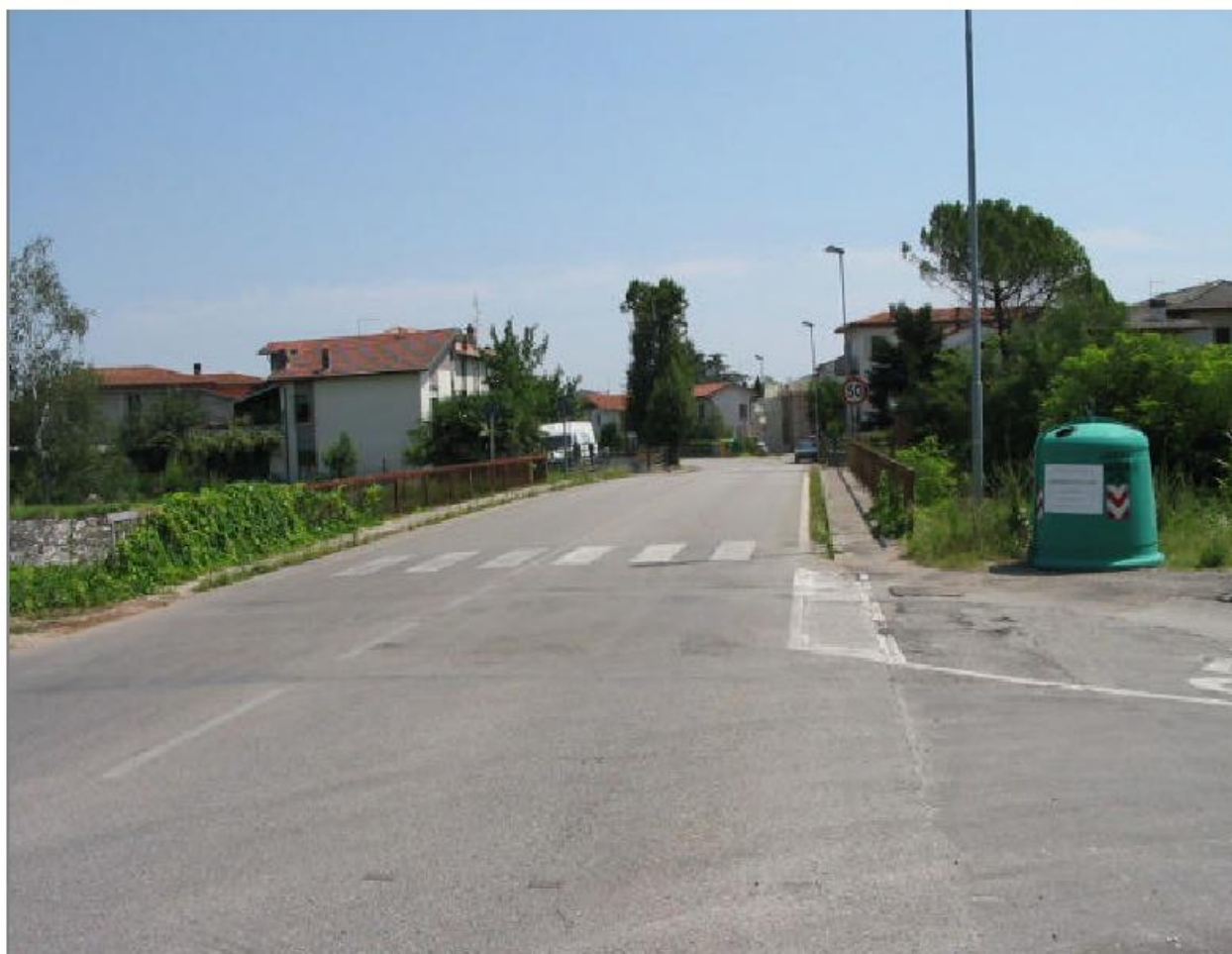
Foto del ponte 3 – Vi.abilità
