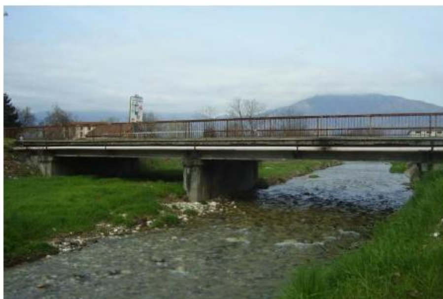
Foto del ponte 1 - Vi.abilità
