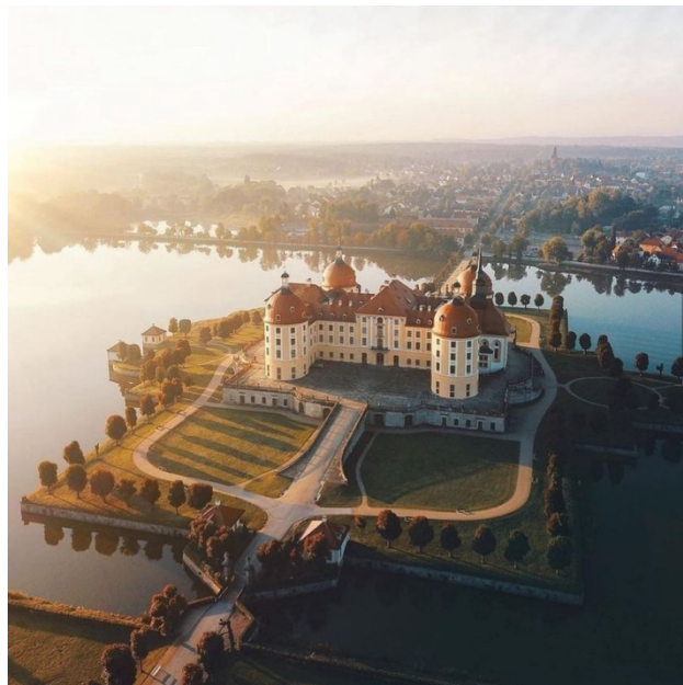
Fig. 95 Fotografia aerea del Castello di Moritzburg
