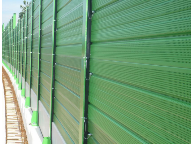
Figura 10 Barriera con pannelli in lamiera metallica in alluminio
