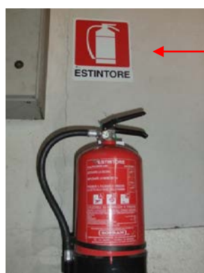
Figura 7.4 – Riposizionamento dell'estintore e verifica presenza cartello di segnalazione
