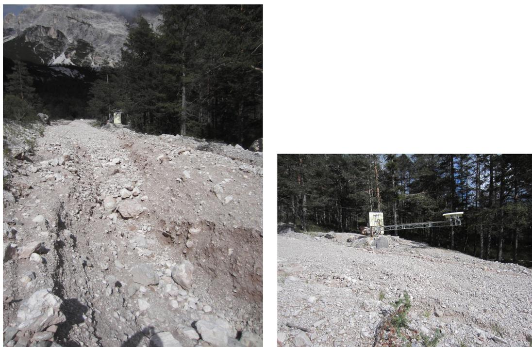
Figura 4.22: Il canale di colata in prossimità della stazione di valle, il 22 agosto 2015. A sinistra: il deposito si interrompe nella zona della stazione di valle; a destra: la quota del deposito è prossima alla quota delle sponde.
