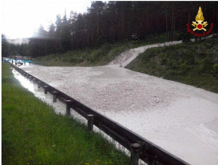
Figura 4.11: Colata di detriti del 23 giugno 2015 in località Acquabona, poco a valle del rio Acquabona.
