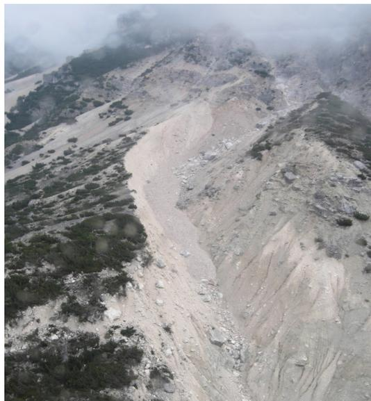
Figura 4.16: Lo sbarramento (a sinistra) che crea accumulo di sedimento più a monte (a destra).
