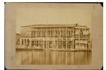
(fig. 2.3) Lavori di restauro, Ponti Carlo, 1861
