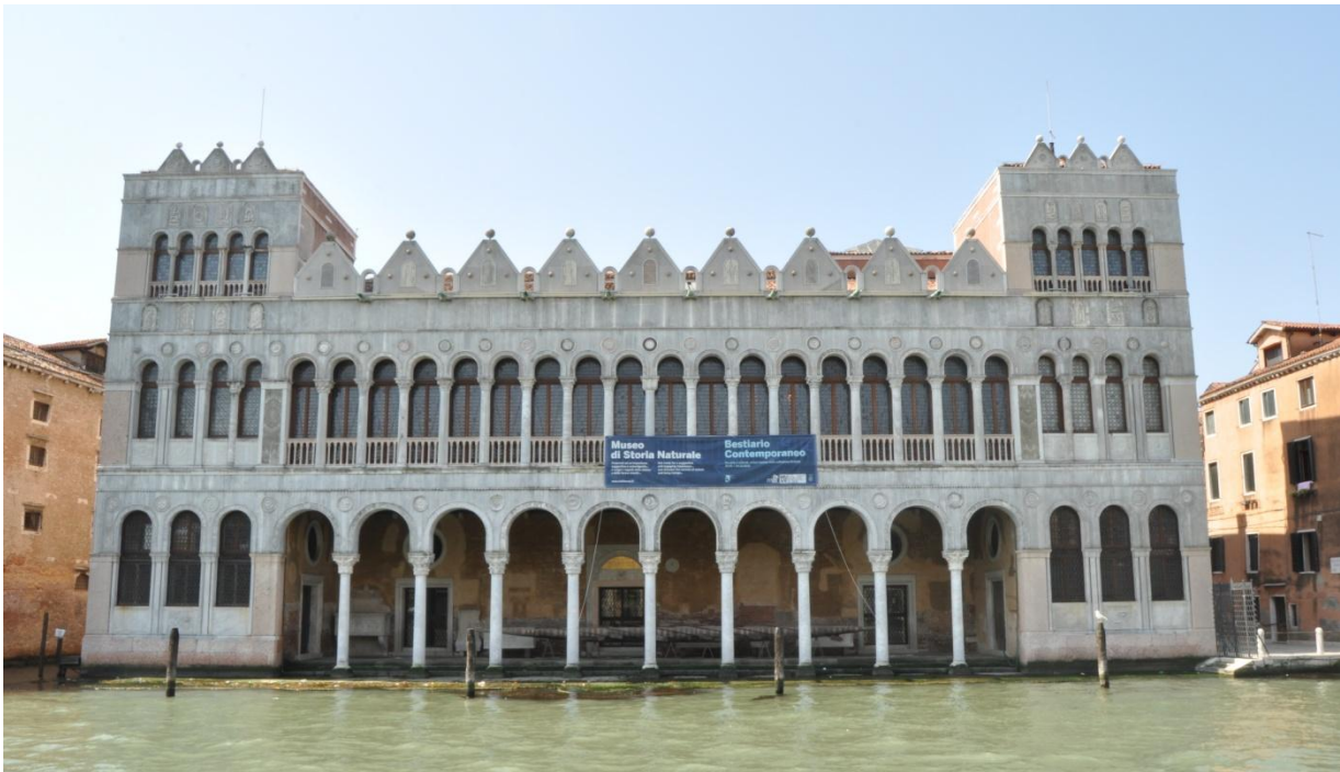
(fig. 2.5) Veduta della facciata del Fondaco dei Turchi sul Canal Grande.
