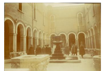
(fig. 3.10) Fotografia storica della corte interna del Fondaco, 1908
