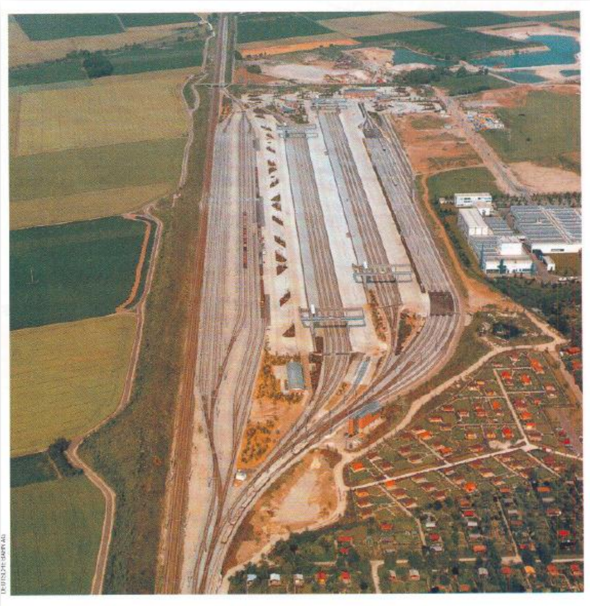
Veduta aerea dell'interporto di Monaco Riem
