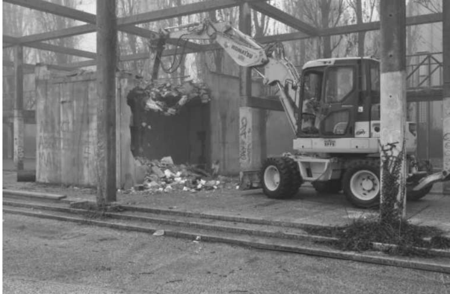
(Abbattimento dei “Cubi” nel 2017 94 )
