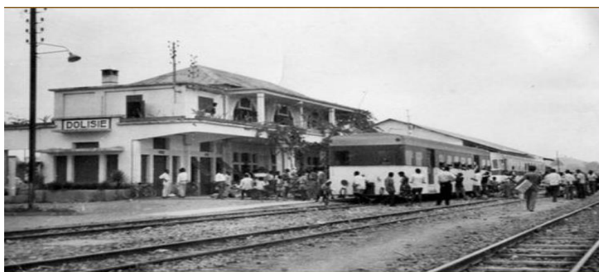
Figure 30. La Gare de Dolisie en 1955
