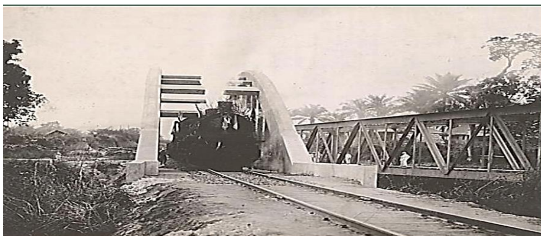
Figure 20: Train sur le Pont du Djoué à Goma Tsé-Tsé
