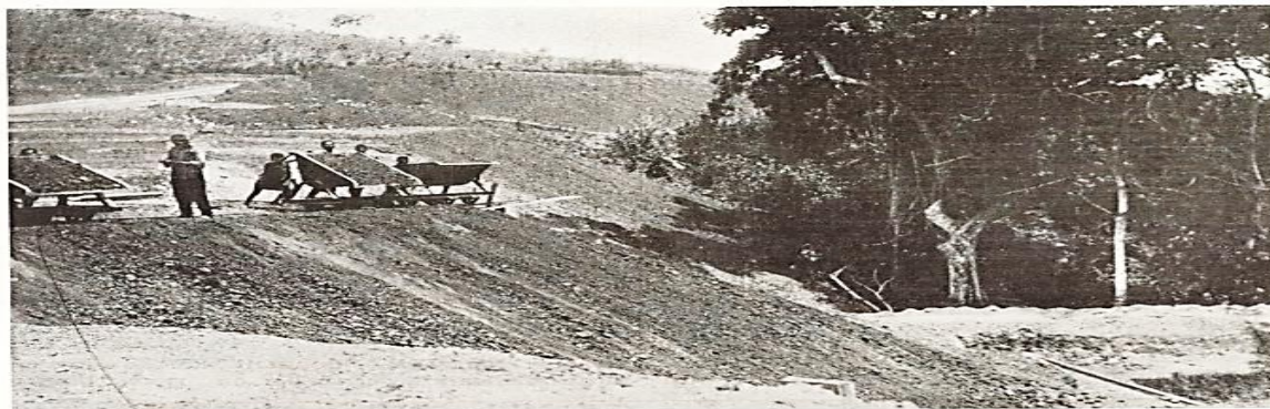
Figure 14: Travaux de terrassement dans la région de Loukoula
