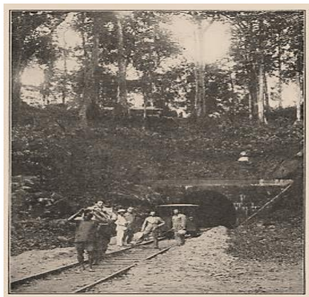
Figure 11: Tunnel dans le Mayombe au kilomètres 90
