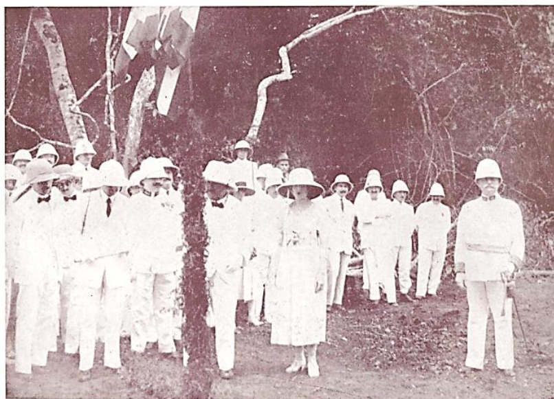
Figure 1 : Le premier coup de pioche de construction du Congo Océan (février 1921) de droite à gauche le gouverneur général Augagneur, Madame Augagneur, Julien Maigret lisant le discours
