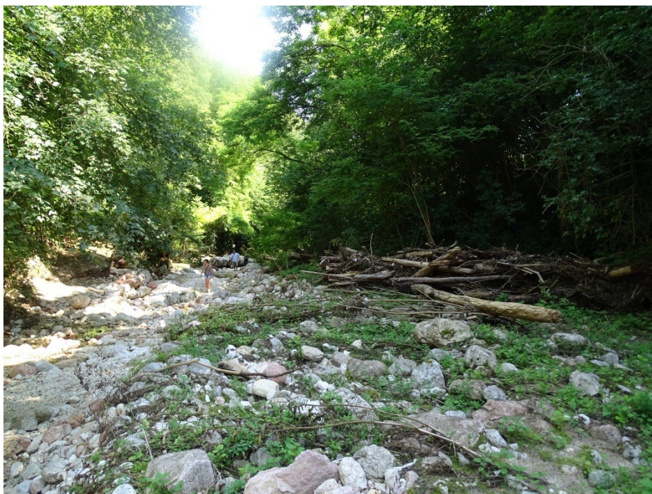
Figura 19: Resti di una rilevante diga di legname ubicata qualche centinaio di metri a monte di località Sul Vago (giugno 2016).
