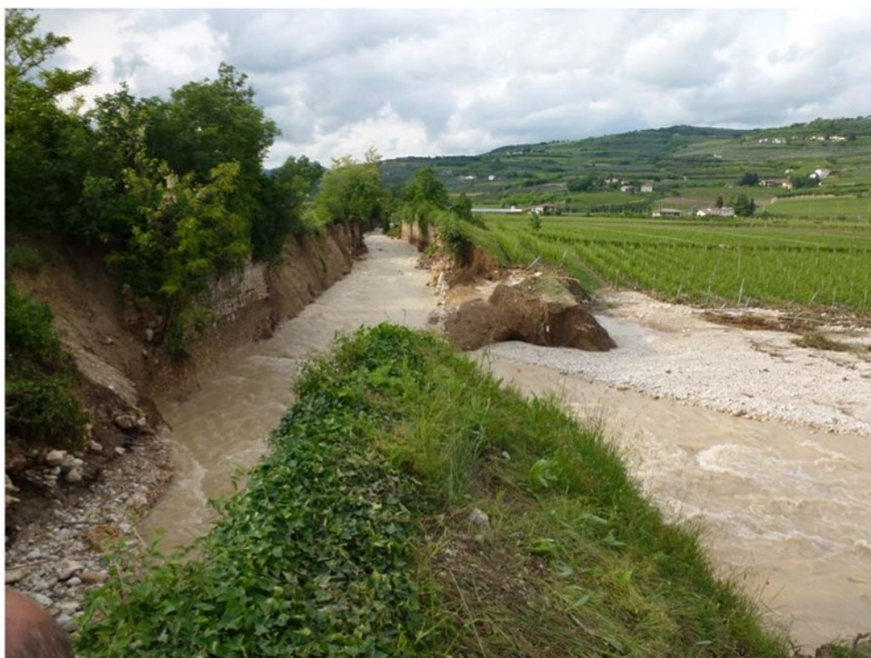
Figura 22: Rottura arginale in loc. Campo Leon – 15 Maggio 2013
