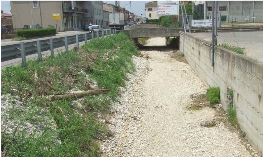
Figura 3: Tratto incassato in corrispondenza di località Vaghetto
