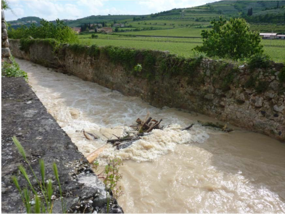
Figura 17: Barriera di legname all'altezza del Comune di Mezzane
