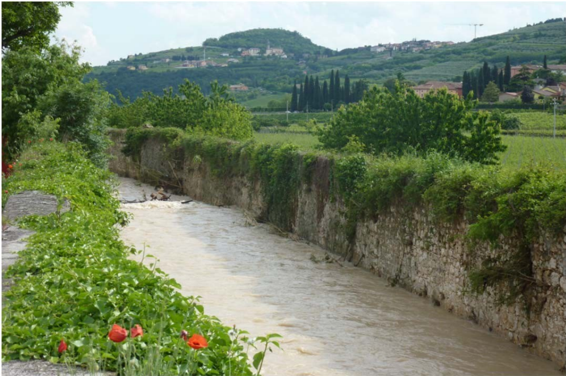
Figura 2: Tratto pensile a monte di località Campo Leon
