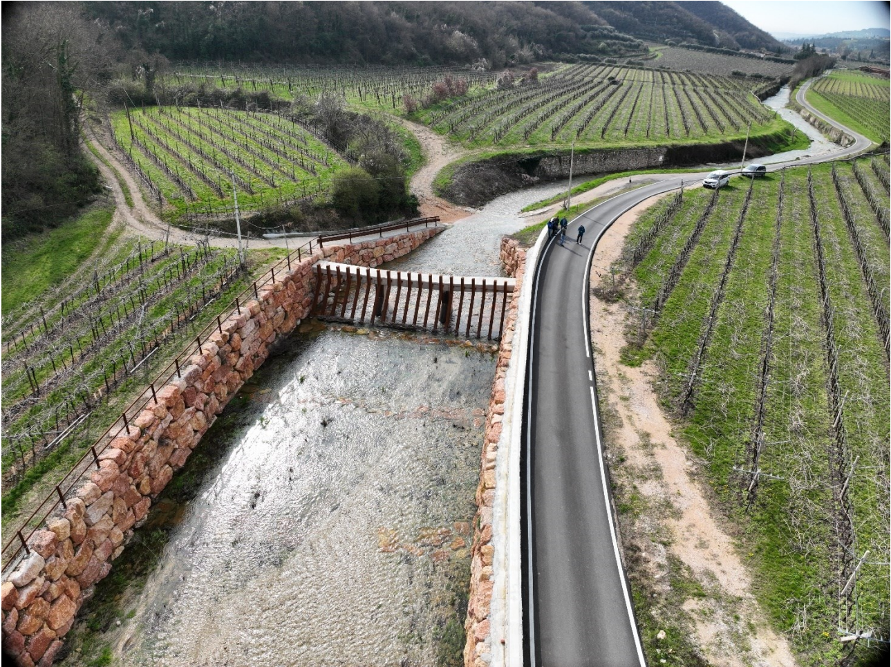
Figura 40: Foto aerea scattata con drone della briglia filtrante
