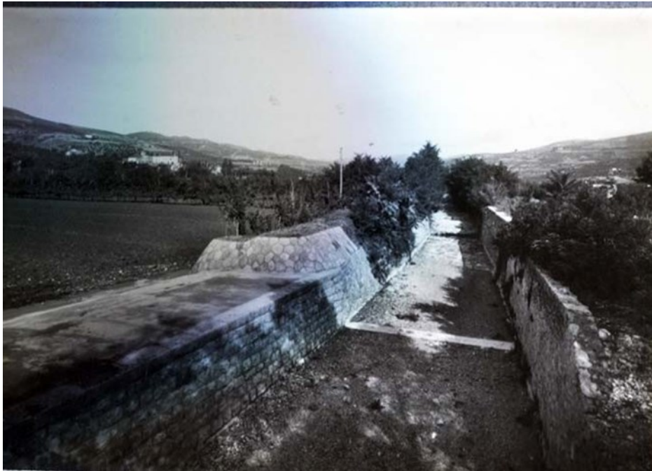
Figura 13: (B) Opera di rientro in destra idrografica immediatamente a monte del ponte di via Fenile. La soglia di rientro è stata chiusa con un argine in terra. Foto del 1935 scattata a seguito dei lavori di ripristino dei danni della piena disastrosa dell'agosto 1934.
