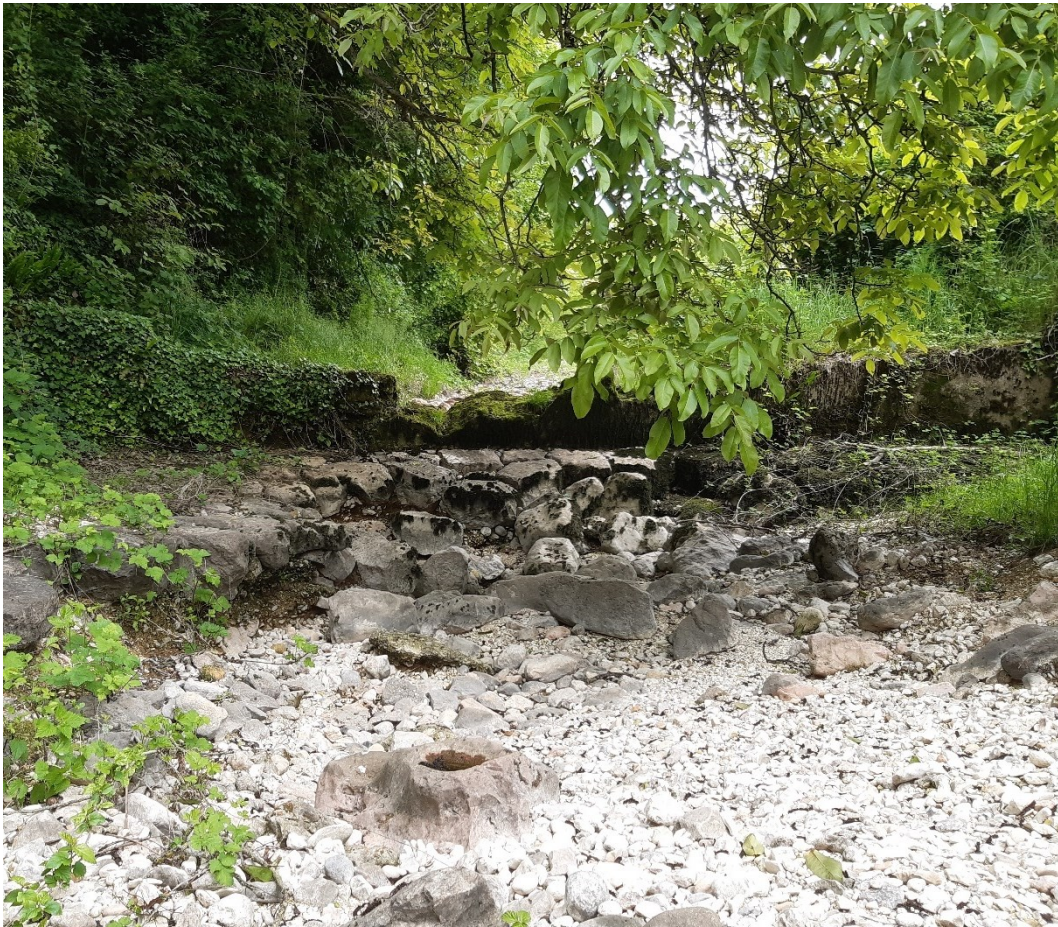
Figura 26: Vecchia opera che chiude il Tratto 1
