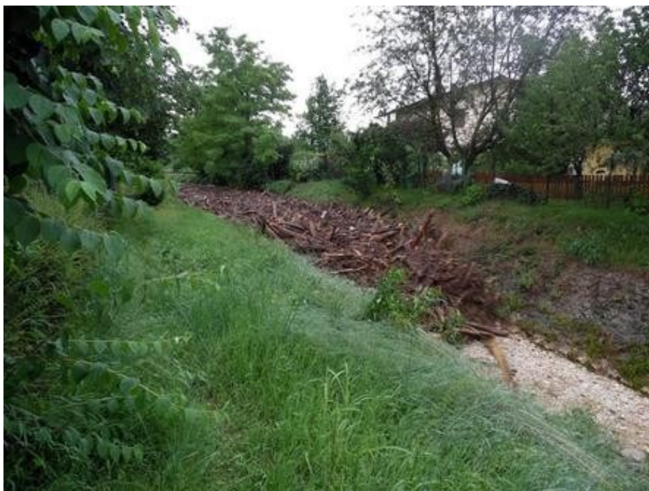
Figura 18: Barriera di legname in testa all'altezza dell'abitato di San Pietro di Lavagno durante l'evento di piena del 8 giugno 2016.
