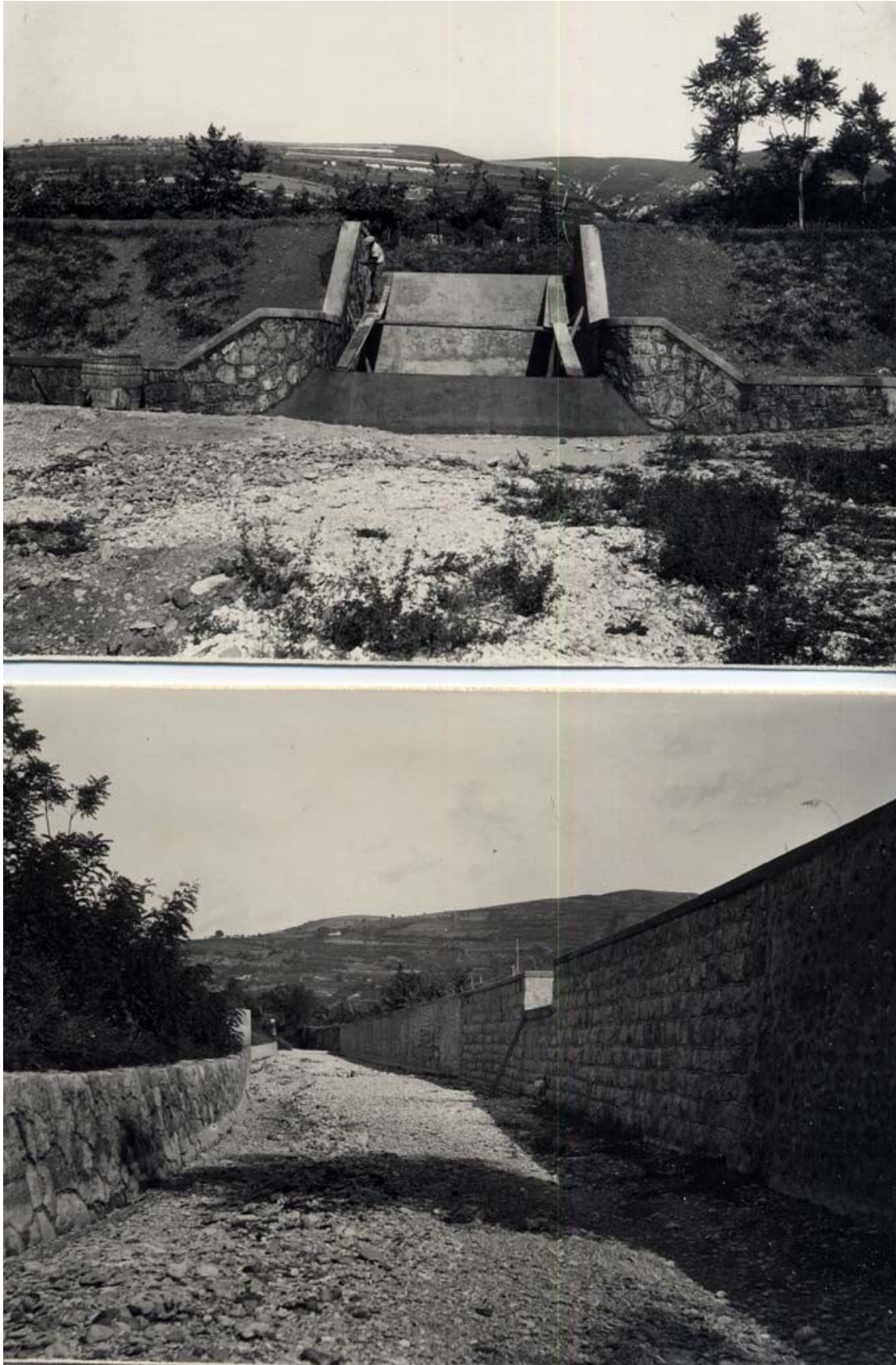
Figura 14: (C) Sfiatore in sinistra idrografica in corrispondenza di Campo Leon. Foto scattata nel 1935 con la conclusione dei lavori di sistemazione del torrente a seguito della piena disastrosa dell'agosto 1934.
