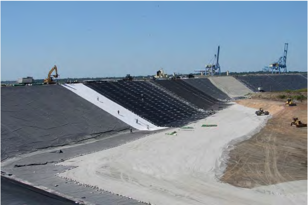
Figura 2-8: Esecuzione della barriera laterale di una discarica
