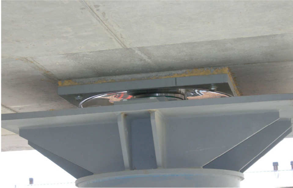
Figura 17: Immagini della piastra con isolatori
