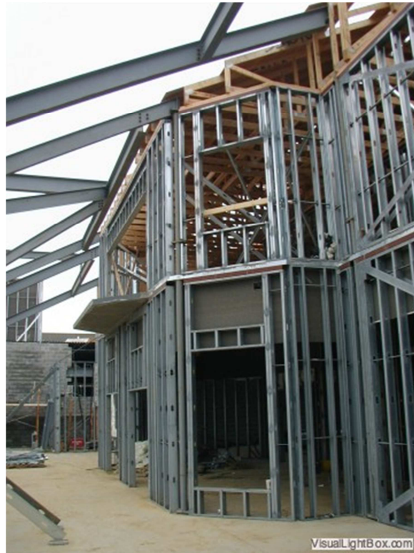
Figura 8: Alcuni edifici che adottano il sistema platform frame utilizzando l'acciaio
