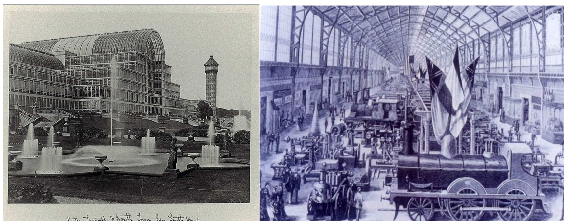
Figura 4: Crystal palace, edificio in acciaio realizzato per l'esposizione universale di Londra 1851
