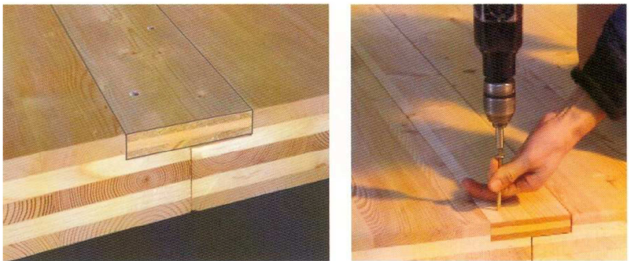
Figura 101: Immagine dei collegamento di continuità solaio - solaio
