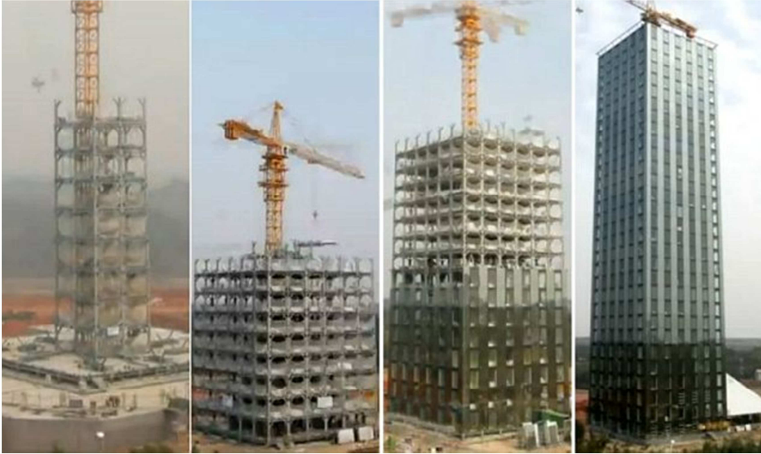
Figura 11: Avanzamento dei lavori dell'edificio sopra citato
