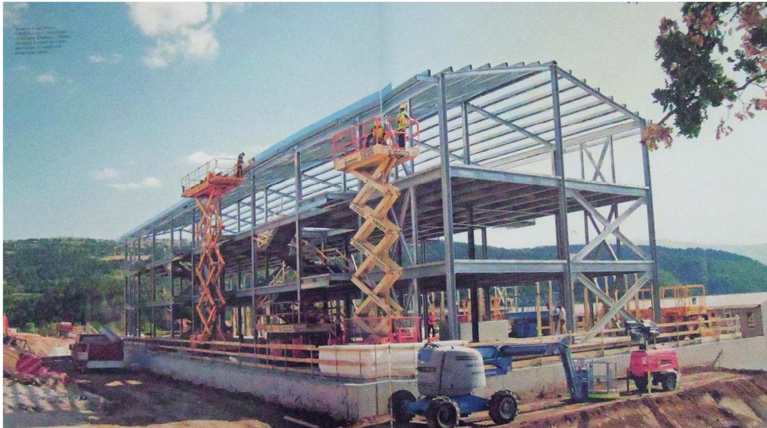
Figura 20: Immagine di un edificio realizzato in gabbia portante in acciaio
