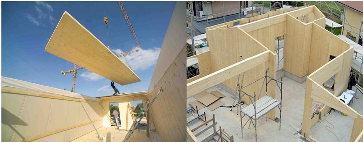
Figura 13: Alcune realizzazioni utilizzando il sistema a pareti strutturali in legno multistrato X-Lam
