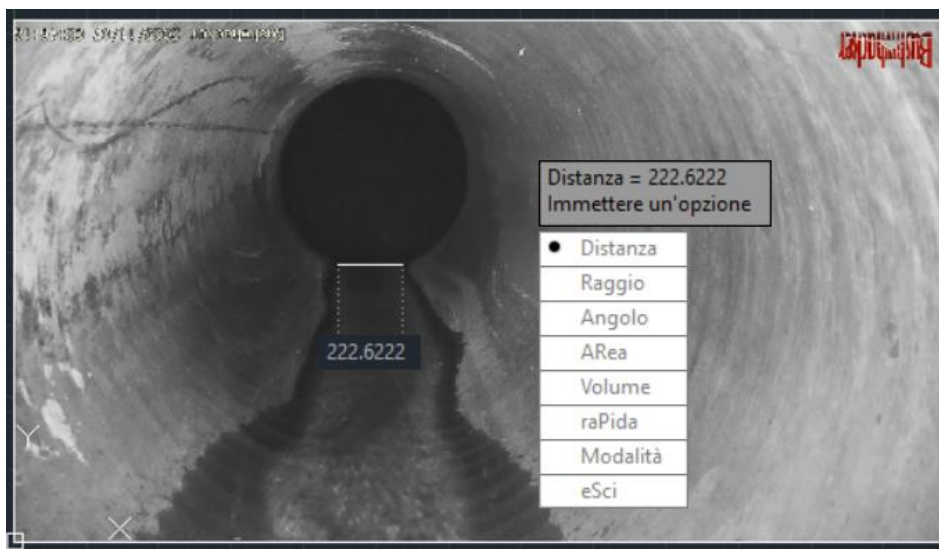
Figura 11: Esempio di misura dello specchio d'acqua ricavata per la sezione 2
