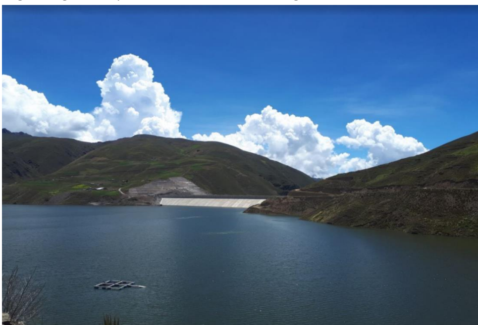
Figura 1.4 Invaso diga Misicuni
