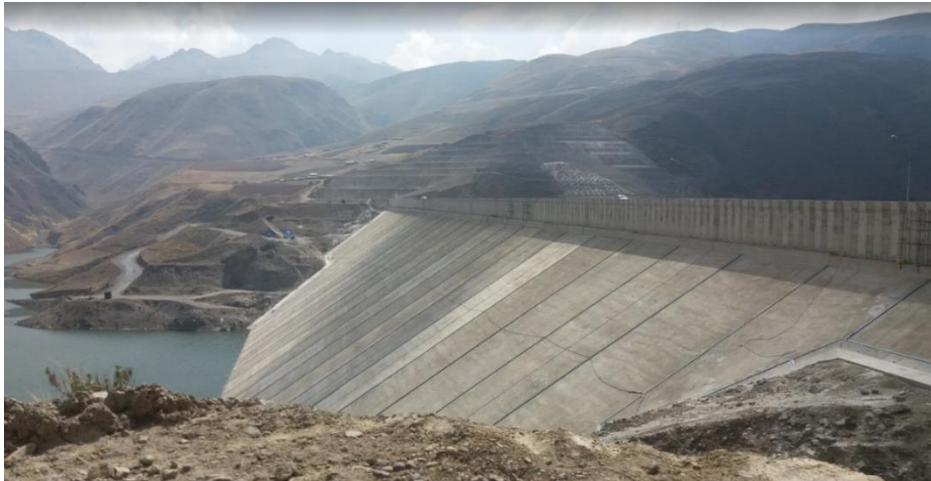
Figura 1.5 Diga in fase di ultimazione
