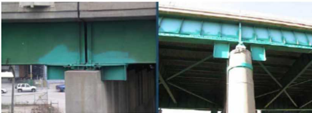
Figura 66 - Esempio di intervento con ritegni esterni
