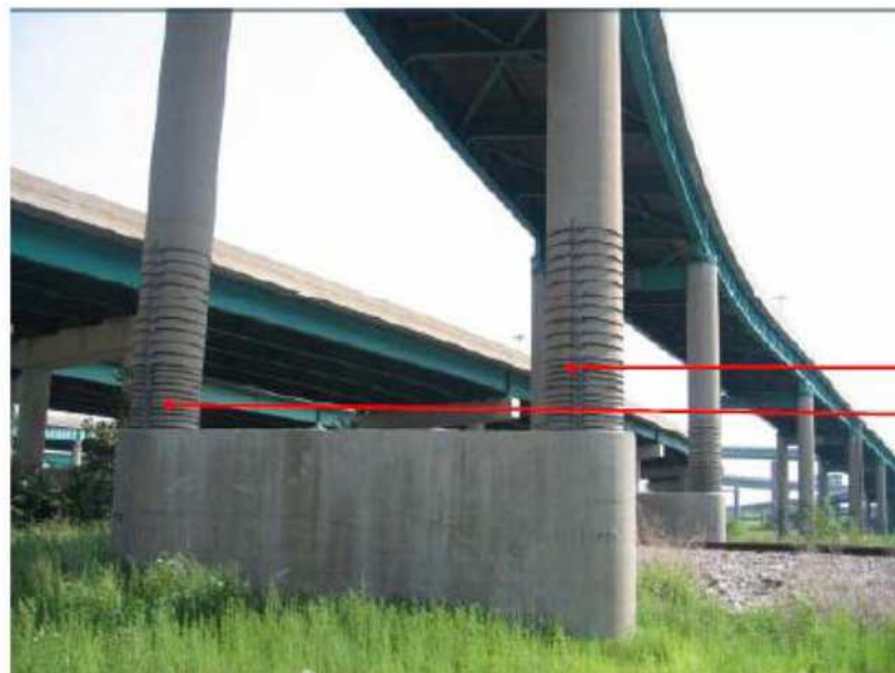
Figura 67 - Esempio di intervento di rinforzo delle pile
