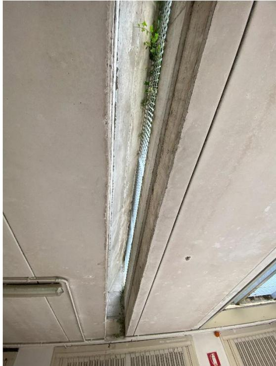
*Figura 25-26: Apertura di ventilazione a soffitto n.1 (a sinistra) e n.2 (a destra)*
