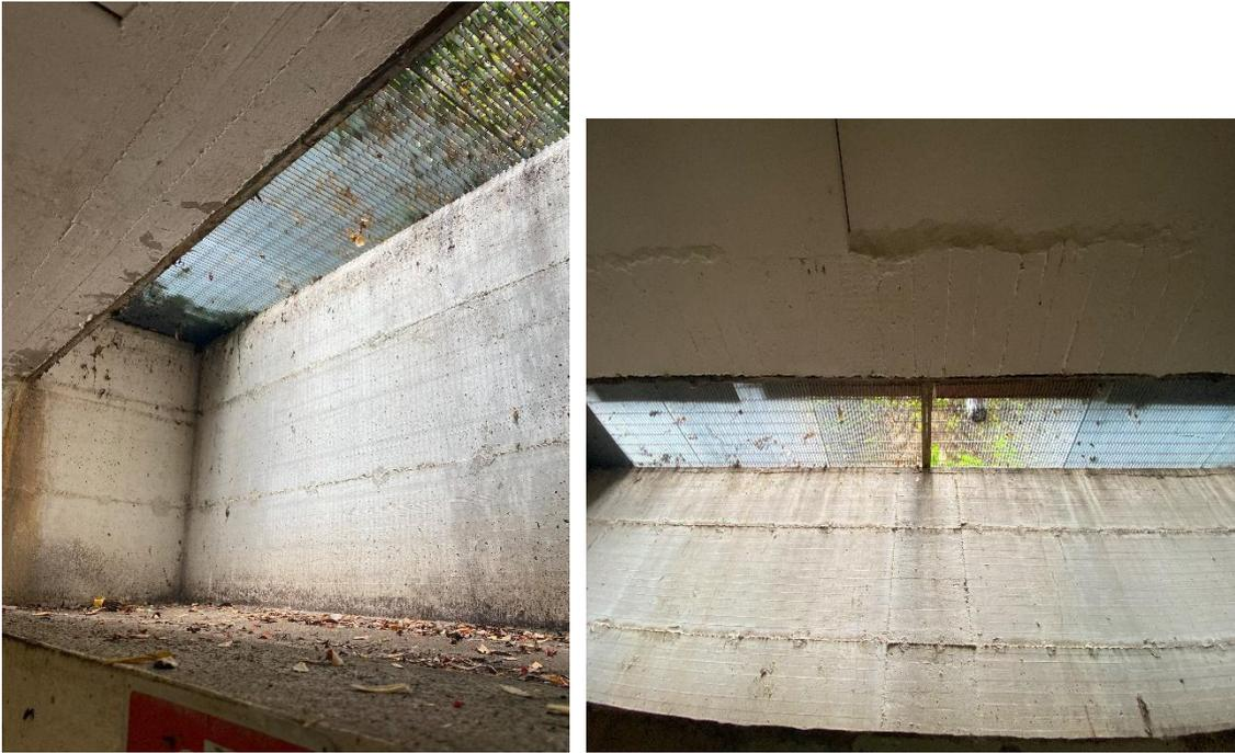
*Figura 27-28: Bocca di lupo in area A (a sinistra) e in area C (a destra)*
