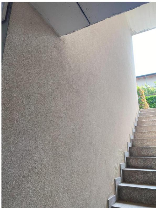
*Figura 12: Assenza apertura di aerazione sul vano scala esterno (area B)*
