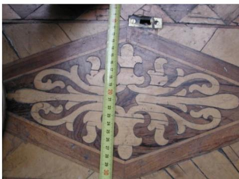
Fig. 3.14 - Particolare della mancata protezione dalla luce solare dovuta alla vernice degradata.
