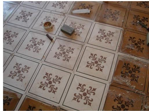
Fig. 3.19 - Posa delle nuove tarsie e levigatura dei "denti" con il raschietto.
