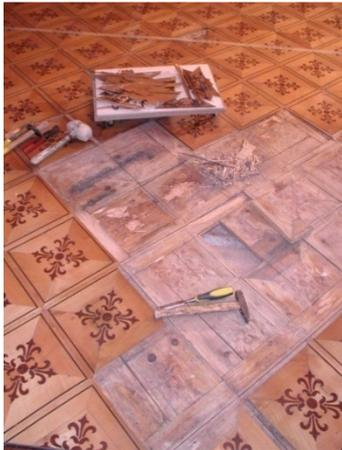
Fig. 3.16 - Rimozione delle tarsie danneggiate in modo irrecuperabile.
