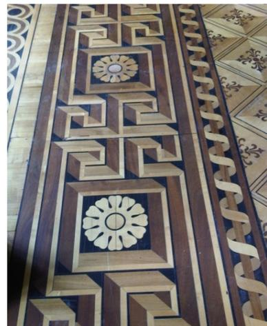
Fig. 3.5 - Particolare degli elementi a fascia e bindello del pavimento della Sala da Ballo.
