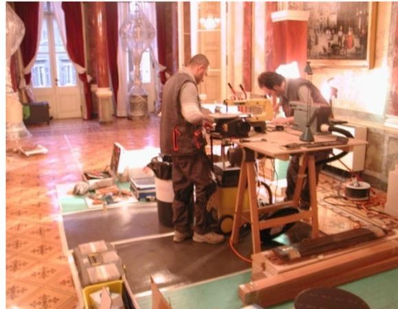
Fig. 3.17 - Operazioni di taglio delle tarsie con il traforo.
