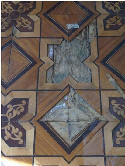
Fig. 3.12 - Particolare del distacco delle cartelle superiori dai pannelli nei punti in cui si è infiltrata acqua.
