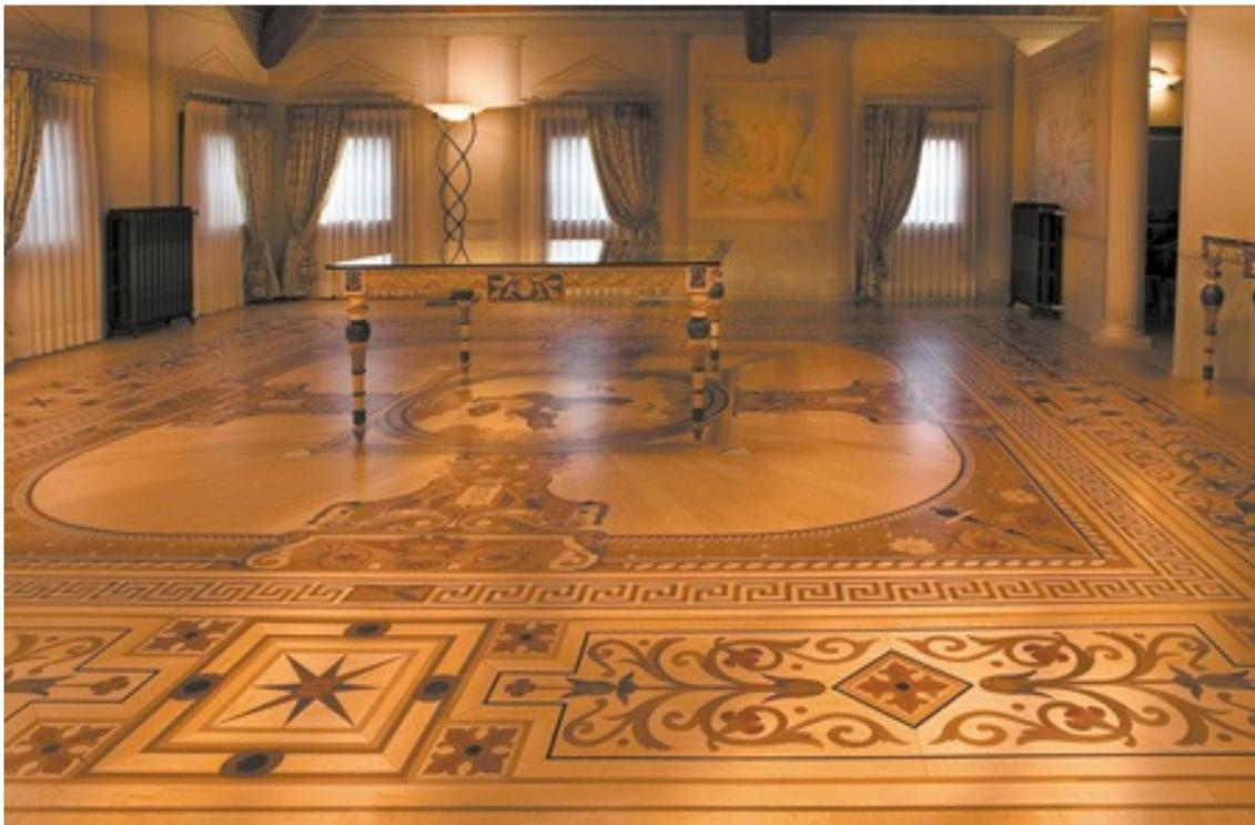
Fig. 1.23 - Disegno ad intarsio moderno realizzato mediante il taglio laser.
