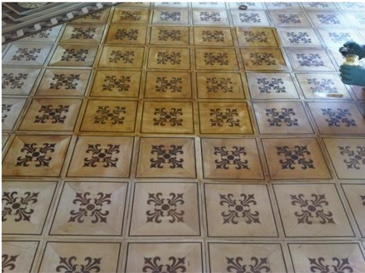
Fig. 3.20 - Stesura della miscela di olio e terre per uniformare il colore dei nuovi elementi in acero con quelli già esistenti.
