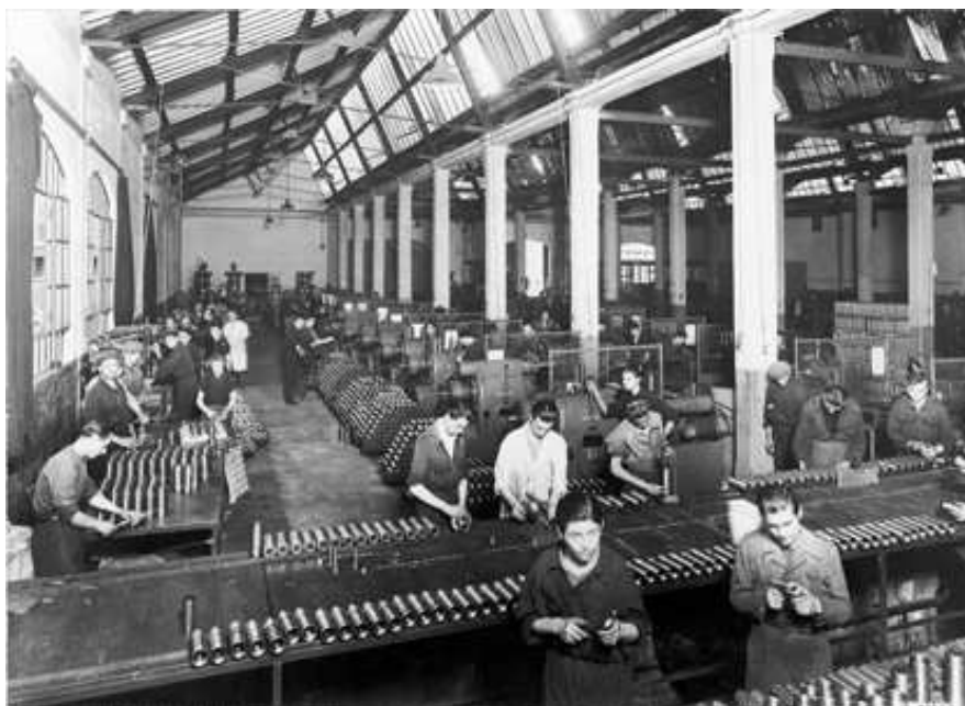
Fig. 24 – Vista interna Officine Breda, 1906, in www.lavecchiapadova.it
