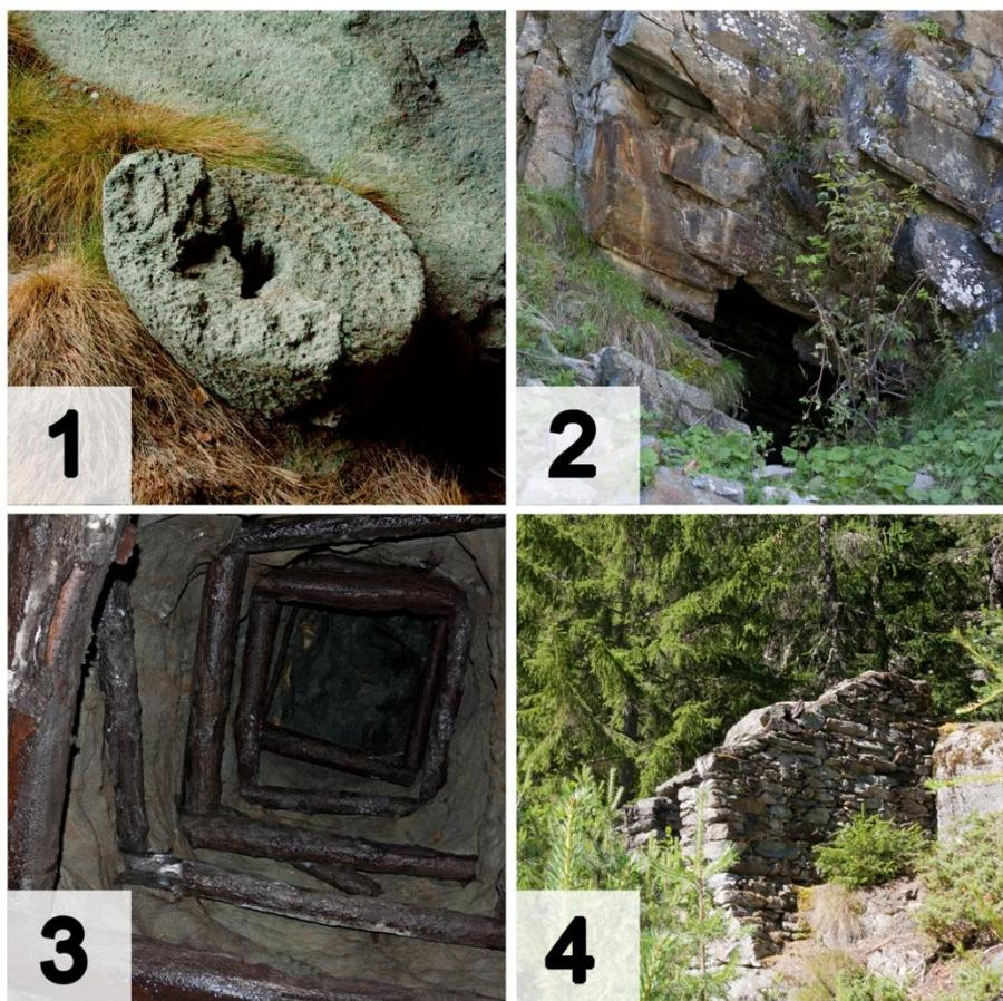
**Figura 5.** (1) Macina presso la cava di Mollière, situata a fianco delle gallerie a quota 1425 m. (2) Imbocco della galleria a quota 1385 m. (3) Camino armato in legno, situato all'interno della galleria a quota 1350 m. (4) Capanno situato nei pressi dell'argine sinistro del t. Clavalité.
