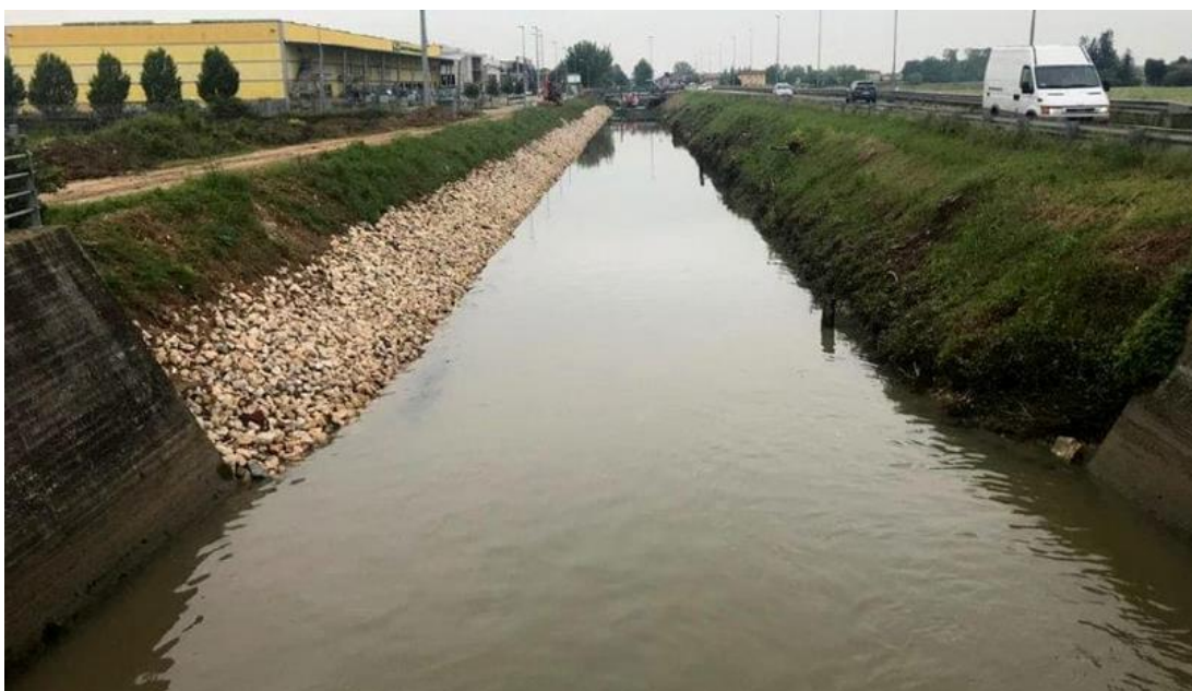
Canale Bisatto a Ponte di Barbarano ad andamento rettilineo spondato.
