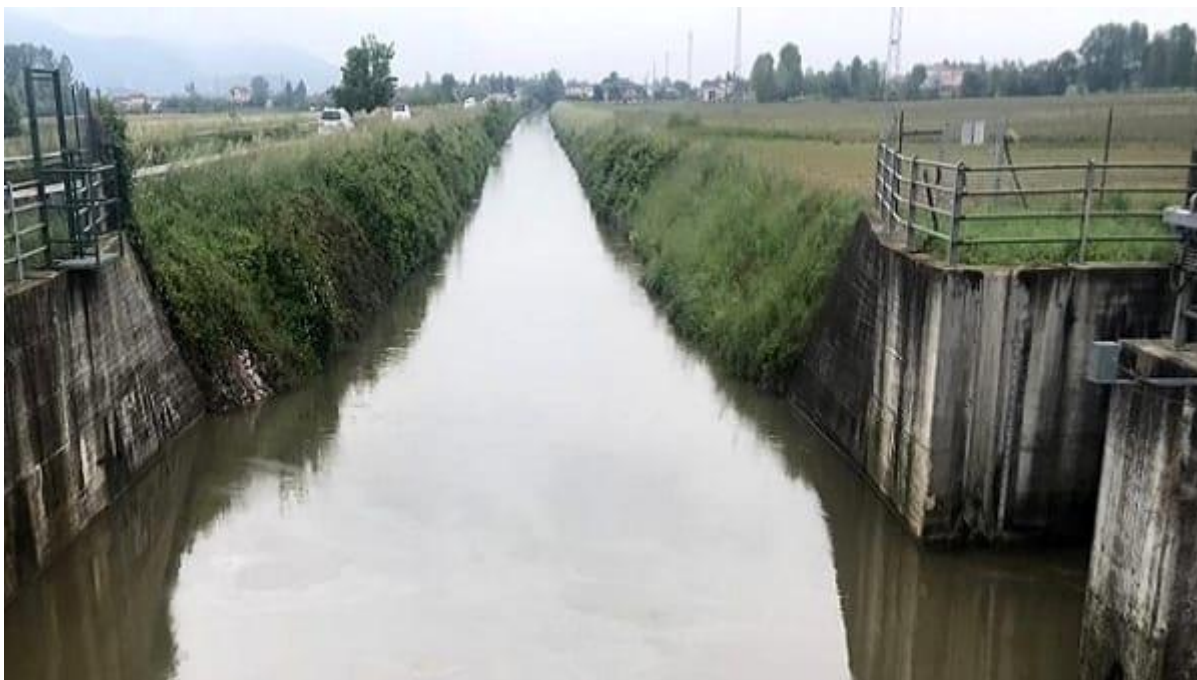
Canale Bisatto con scavo e sponde ad andamento rettilineo.
