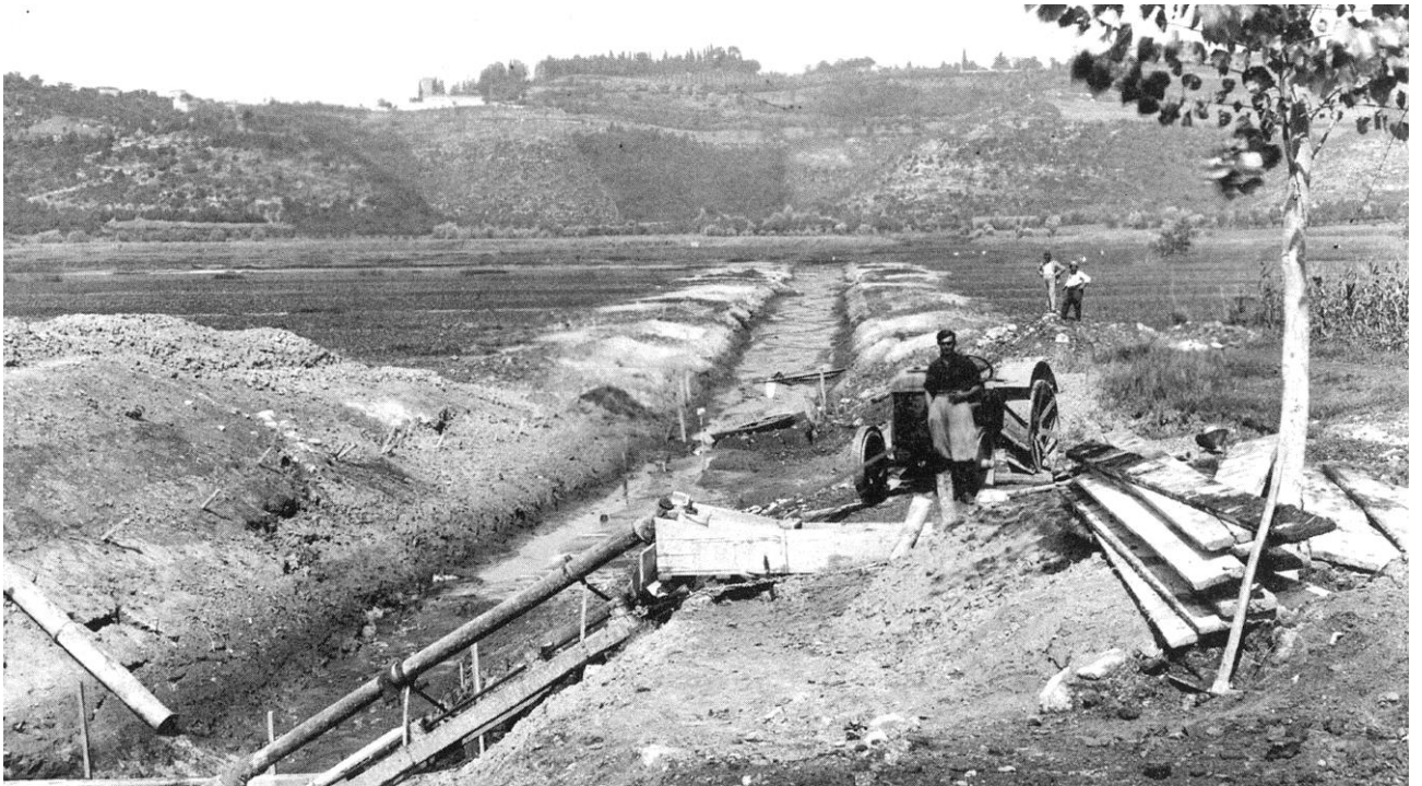
Scavi di bonifica alla Fontega di Arcugnano, anni Trenta.
