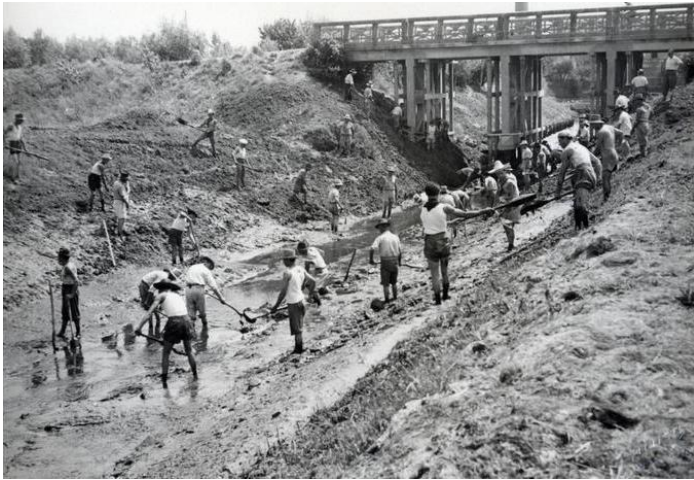
Scavi al ponte di Debba.
