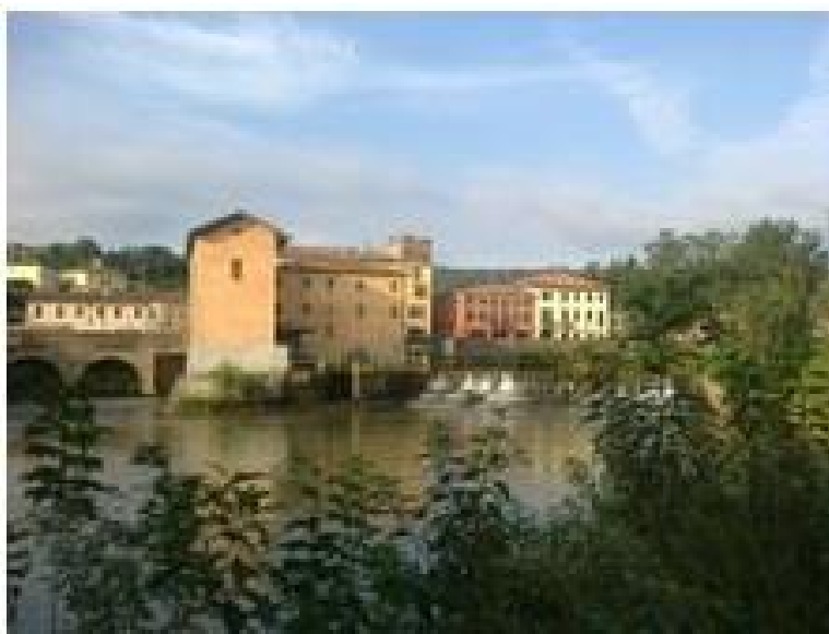
Casello idraulico di Colderuga a Longare.
