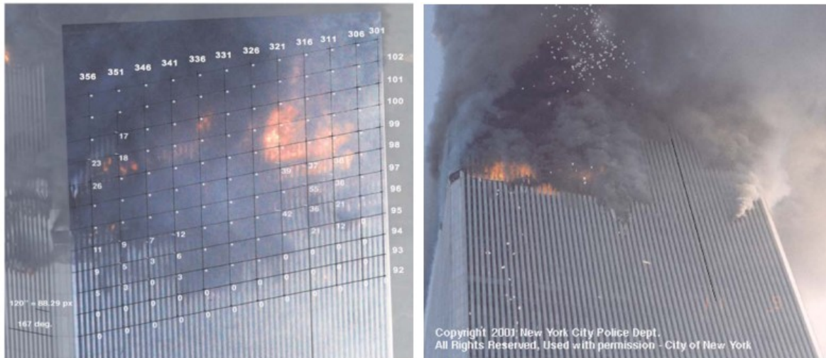
Figure 3.35 e 3.36. Le due immagini, che ritraggono la facciata Sud del WTC 1, sono state scattate rispettivamente alle 10:23°A.M. ed alle 9.25 A.M. del 11/09/2001 (S.W. Banovic, T. Foecke, and F.W. Gayle (2006), Assessment of Structural Steel from the World Trade Center Towers, Part V: Forensic Photographic Evidence of Tower Collapse Initiation and Progression ).
