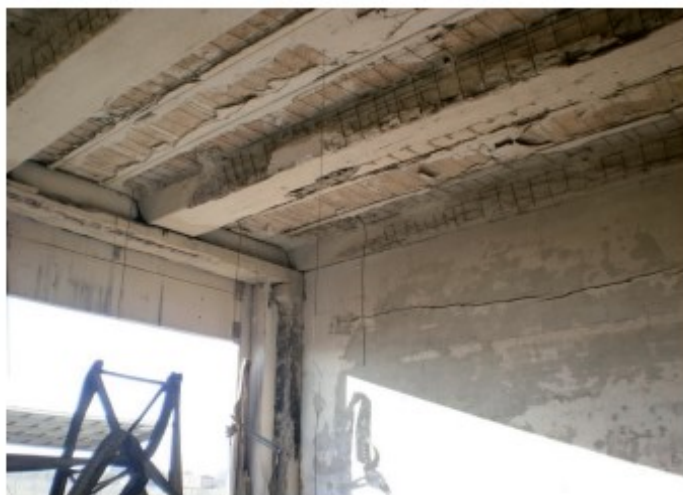
Figura 4.4. Quadro del danneggiamento provocato alla colonna 6 ed alla parete di compartimentazione (Flavio Stochino, Fausto Mistretta, Paola Meloni, Gianfranco Carcangiu (2017), Integrated Approach for Post-fire Reinforced Concrete Structures Assessment ).
