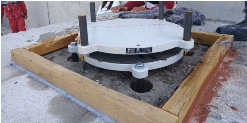
Figura 5-1: due foto dall'alto dell'ospedale e foto del montaggio di un isolatore.
