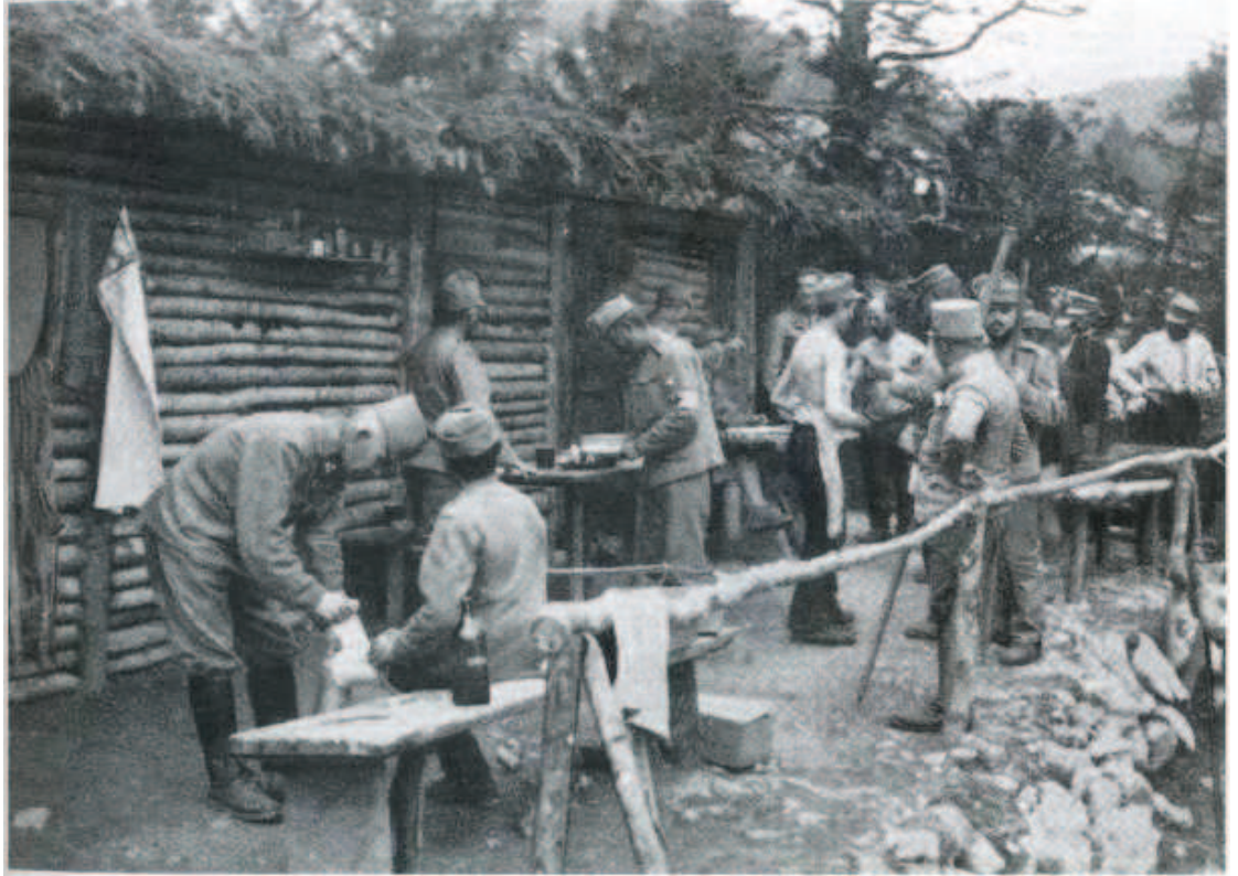
Figura 22 Ospedaletto da campo con struttura a blockbau in Val Galmarara [Seccia, cit., pag. 185]
