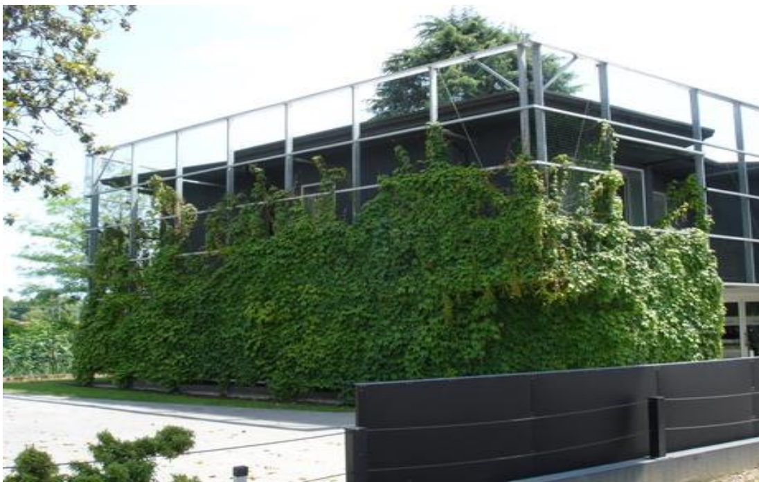
Figura 12: esempio di rivestimento vegetale realizzato con vite vergine (da files.modulo.net)
