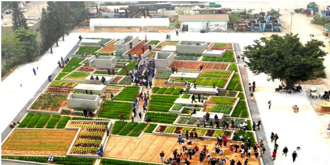
Figura 10: vista dall'alto di "Value Farm" (da fotovoltaicosulweb.it)
