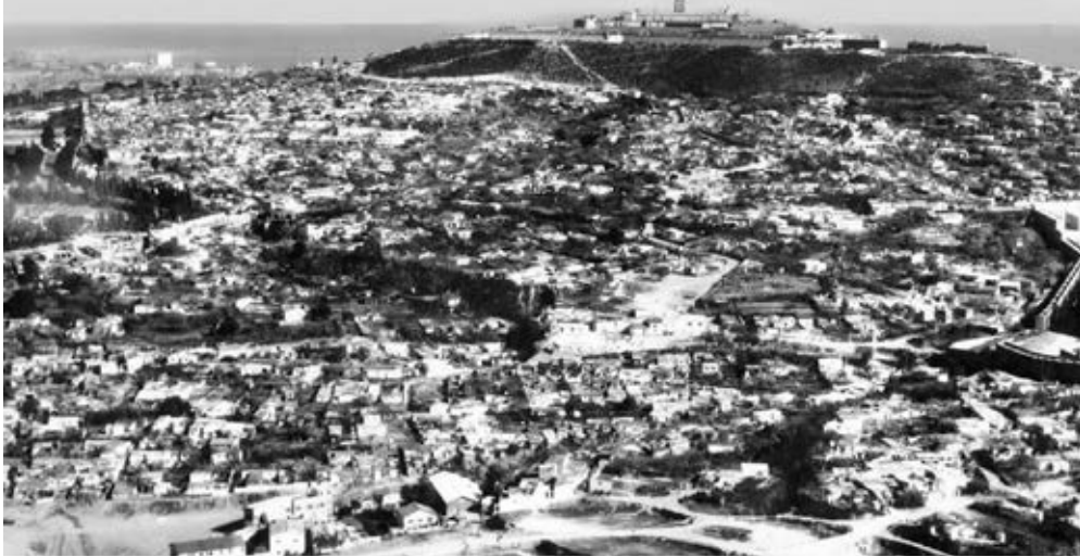
Barraquismo nella zona di Montjuïc
