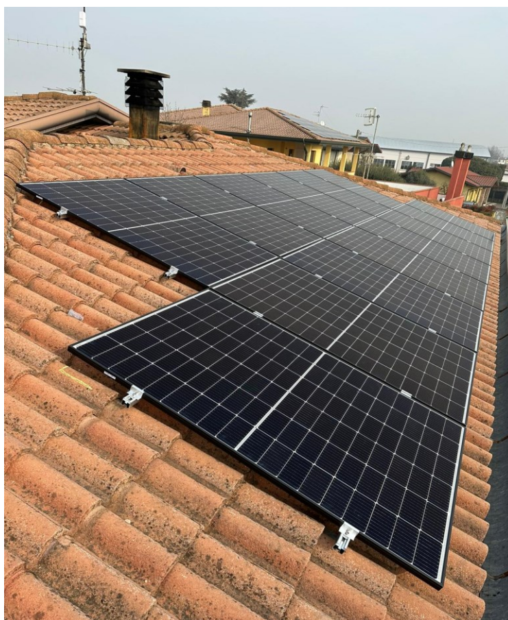
Figura 2.2: Fissaggio dei pannelli sul tetto 24 .
