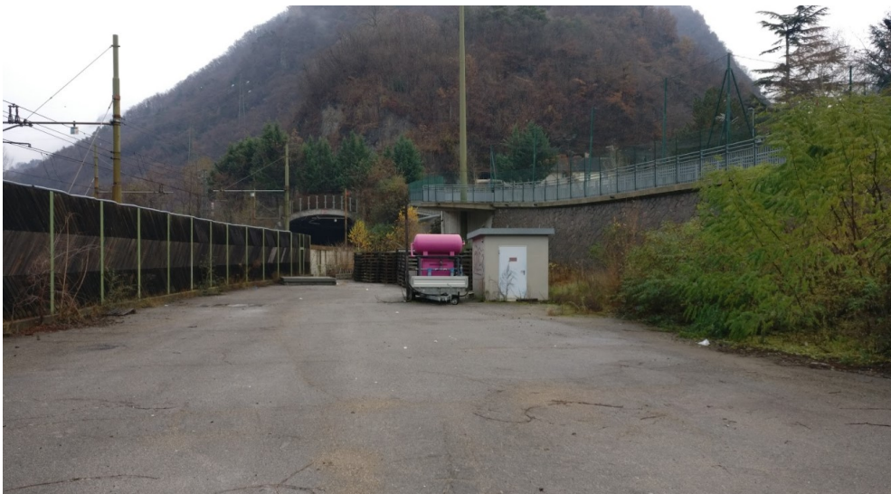
Figura 4.5 Piazzale prima dell'imbocco di galleria
