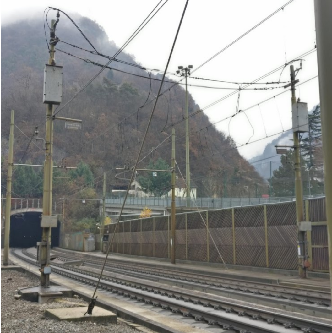
Figura 4.1 Imbocco Nord di galleria
