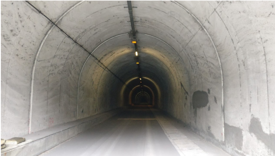
Figura 4.9 Tunnel verso la galleria ferroviaria
