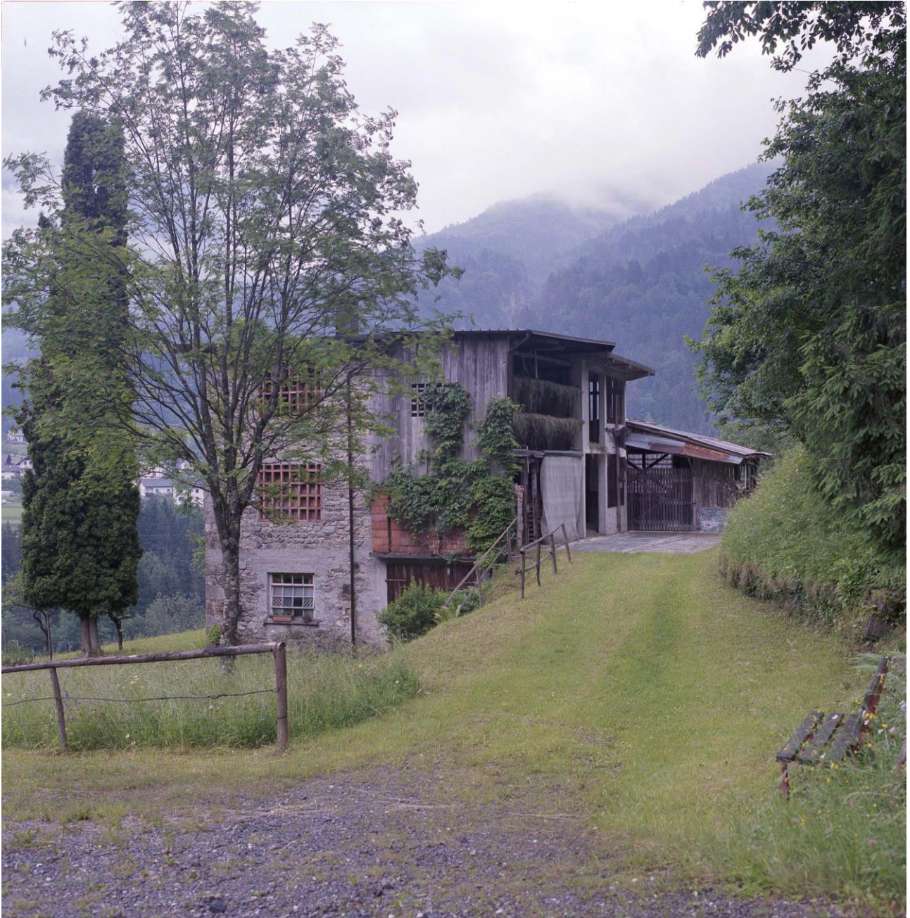
Edificio rurale con foraggio in fase di essiccamento
