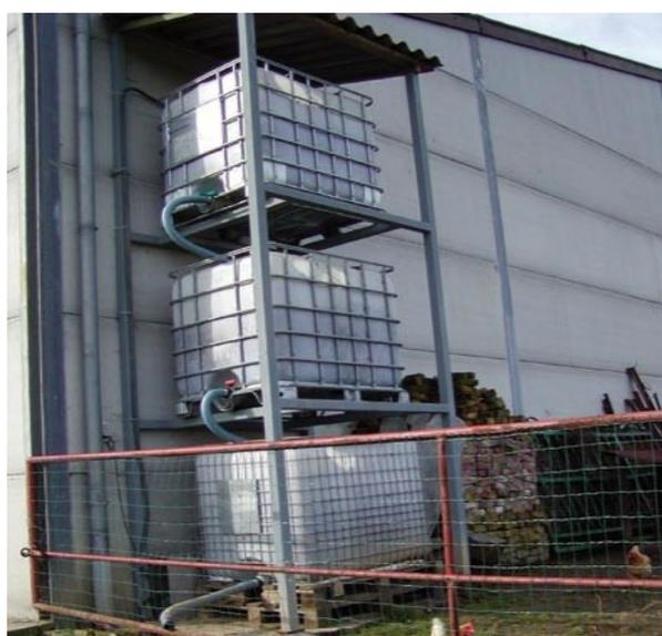
Figura 6: Esempio di biofiltro multiplo.
