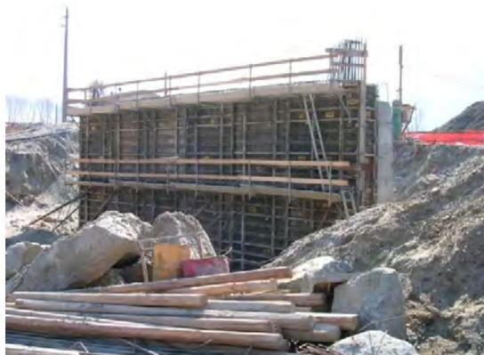
**Figura 351.** Cassero a telaio per il getto delle spalle (2/2)
