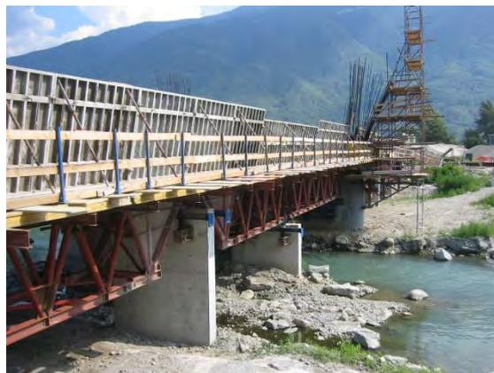
Figura 396. Casseri a telaio per getto travi di bordo
