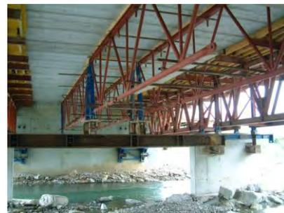
Figura 381. Travi di sostegno centrali T30
