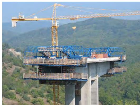
**Figura 329.** Coppia di carri per costruzione simmetrica
