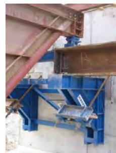
Figura 387. Mensola speciale di appoggio su spalle
