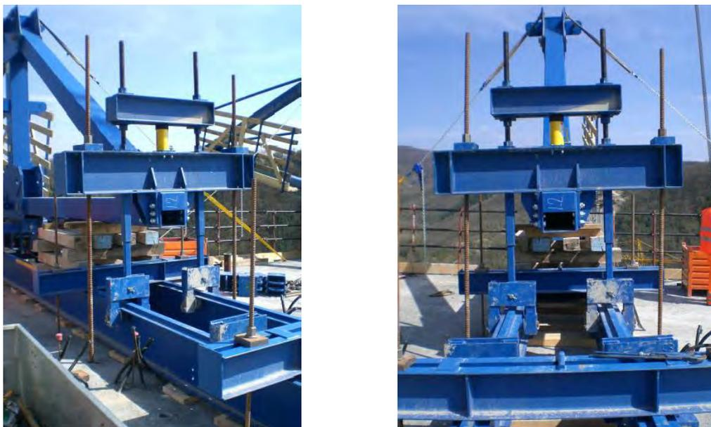
**Figura 327.** Ancoraggio al getto precedente e messa a piombo del carro
