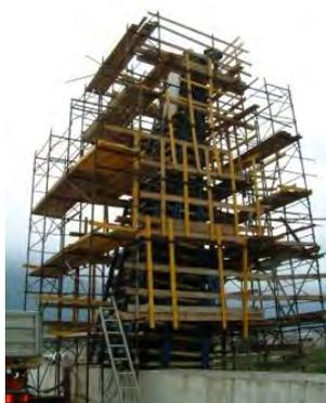
**Figura 423.** Ponteggio per getto antenne
