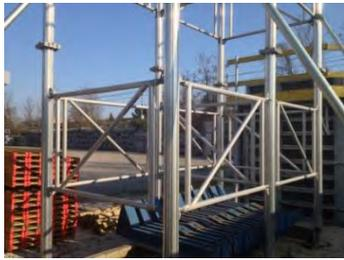
**Figura 309.** Esempio telai di collegamento
