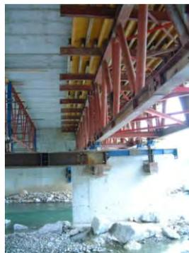
Figura 380. Travi di sostegno laterali T50
