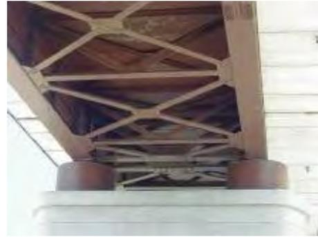
Figura 13. Traversi reticolari in un impalcato in struttura mista acciaio-calcestruzzo
