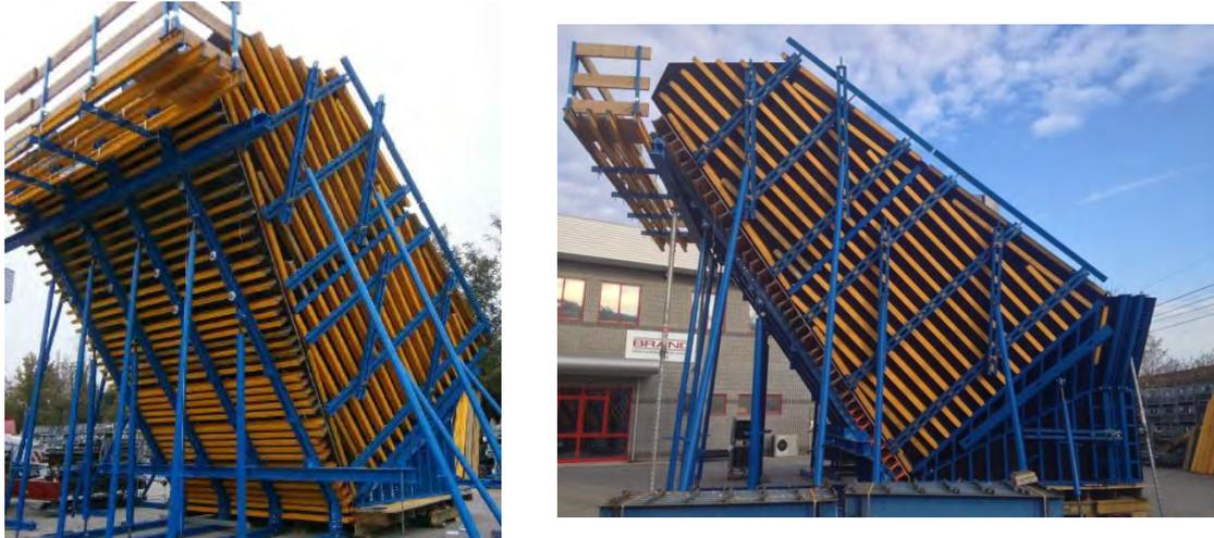
**Figura 219.** Esempio di cassero a trave per il getto di un pulvino
