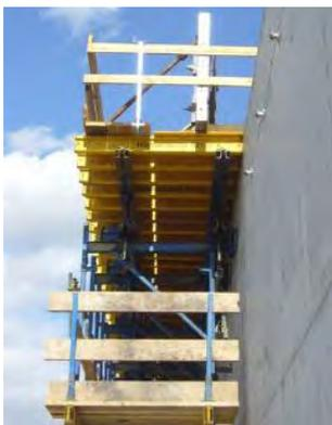
Figura 366. Sistema di rampata KK
