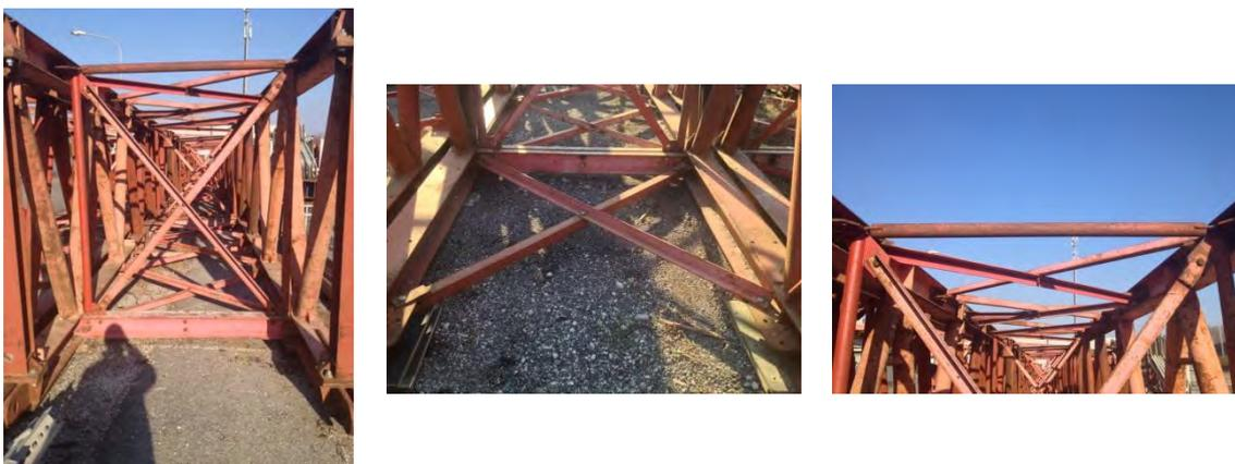
Figura 412. Elementi di controventatura standard
