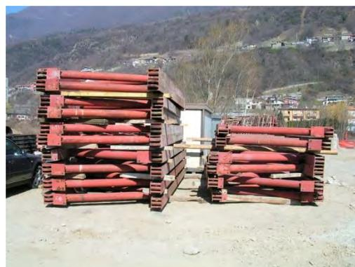
**Figura 394.** Travi reticolari portanti smontate
