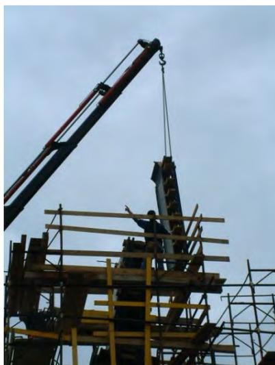
Figura 420. Montaggio della cassaforma per il getto delle antenne
