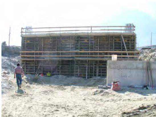
**Figura 350.** Cassero a telaio per il getto delle spalle (1/2)
