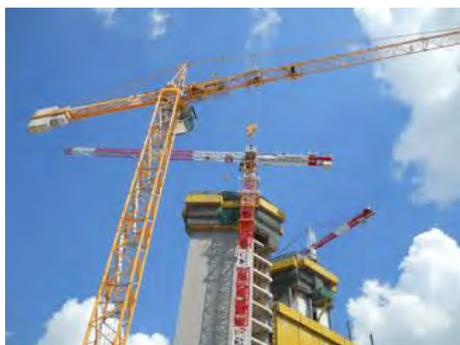
Figura 123. Esempio di gru a torre
