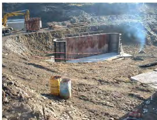
**Figura 349.** Cassero a telaio per il getto della pila
