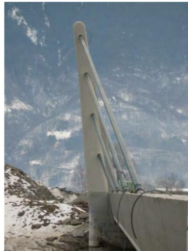
**Figura 427.** *Stralli di sospensione del ponte sul fiume Adda*
