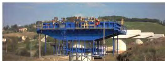
Figura 131. Esempio di cassaforma rampante per pulvino
