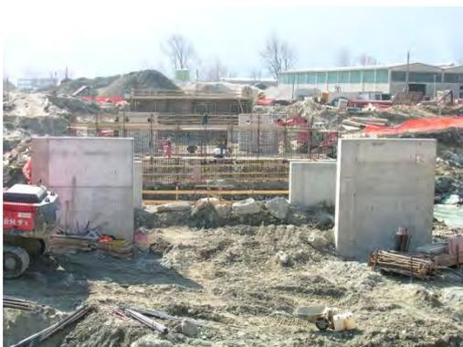
Figura 371. Pile provvisorie di appoggio
