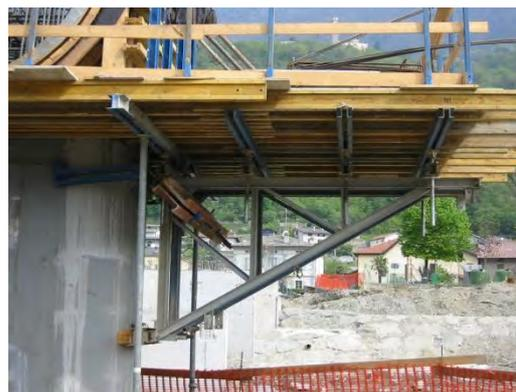
Figura 359. Mensole di rampata HSB con ancoraggi
