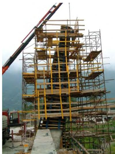
Figura 421. Cassaforma completa per il getto delle antenne
