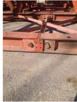
**Figura 405.** *Correnti inferiori connessi*
