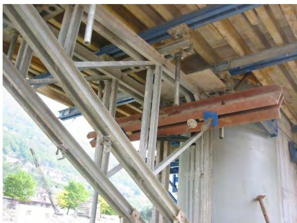
Figura 360. Corrente doppio UNP di ancoraggio (si notino anche le aste filettate)
