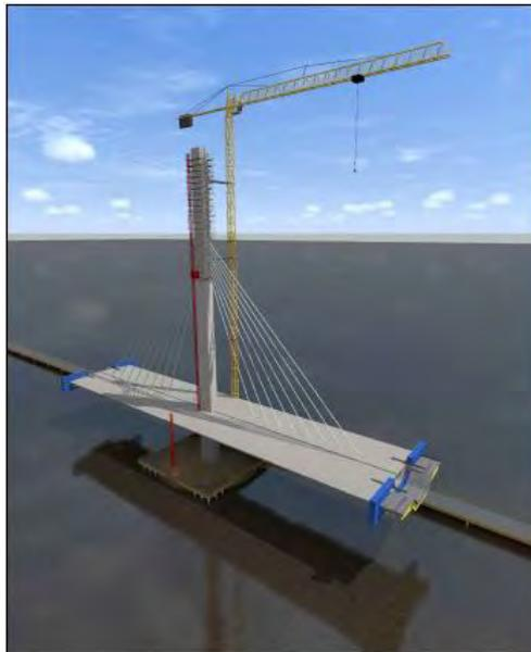
**Figura 320.** *Costruzione a sbalzo dell'impalcato del Mersey Gateway Bridge*
