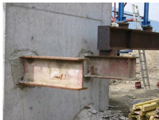
Figura 374. Correnti per appoggio travature reticolari
