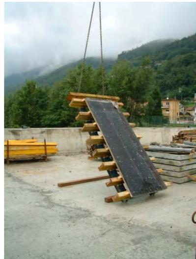
Figura 418. Pezzi del cassero per il getto delle antenne
