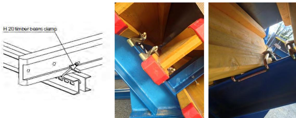
Figura 187. Esempi di collegamento trave-corrente
