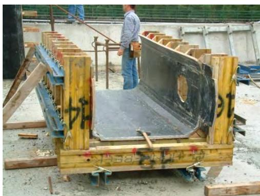
**Figura 425.** Dettaglio foro per collocamento sella di appoggio
