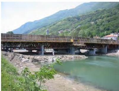
Figura 378. Travate reticolari di sostegno per getto impalcato (1/2)
