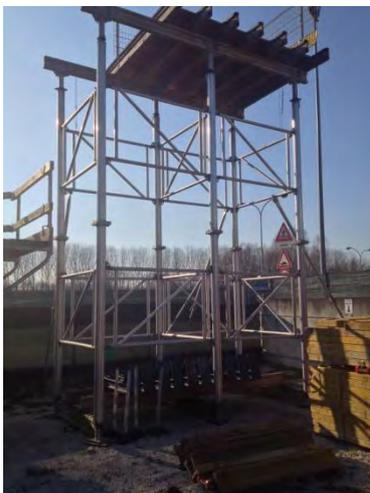
Figura 299. Esempio di torre GASS
