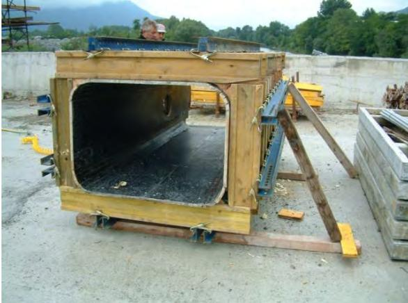
Figura 416. Cassero a trave per il getto delle antenne
