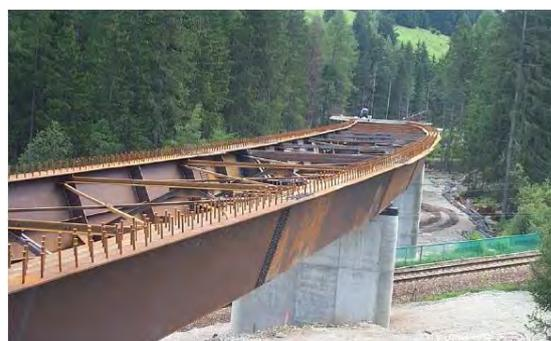
**Figura 25.** Impalcato a cassone in struttura mista in fase di costruzione
