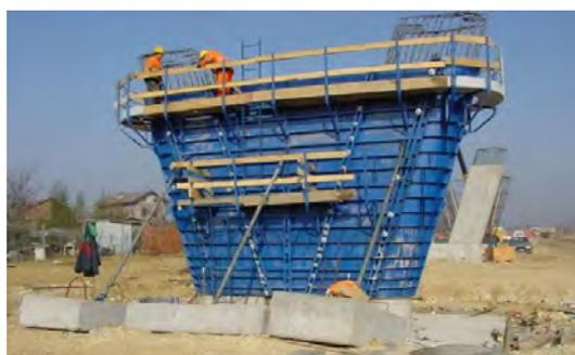
Figura 162. Cassaforma speciale in acciaio per pila
