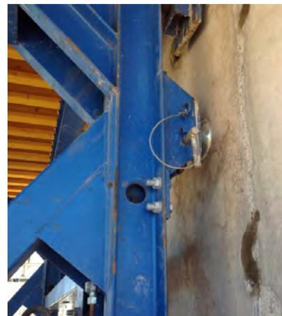
Figura 237. Dettaglio dell'ancoraggio del sistema di rampata HSB
