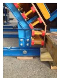
Per movimentare tutta questa attrezzatura, per sollevarla e metterla in posizione attraverso l'utilizzo della gru, si dispongono nelle pareti più inclinate, bullonandole ai correnti di orditura primaria della cassaforma, altri correnti orizzontali sui quali si saldano dei piatti forati per permettere l'aggancio delle catene di movimentazione (Figura 215).
