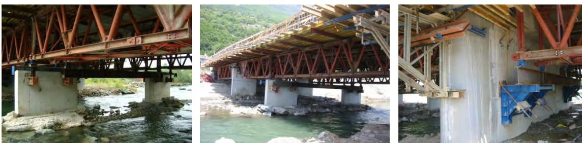
Questa soluzione ha permesso di appoggiare le travi centrali a media portata T30 solo sui suddetti profilati d'appoggio, evitando così la realizzazione di ulteriori quattro pareti provvisorie che avrebbero comportato ulteriori ed inutili spese; questo perché il carico trasmesso agli appoggi dalle travi T30 era modesto e tale che vi potesse resistere solo il corrente d'appoggio.
