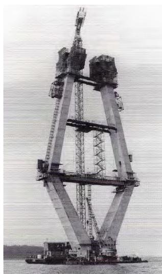
**Figura 126.** *Pilone del Farø Bridge in fase di costruzione*
