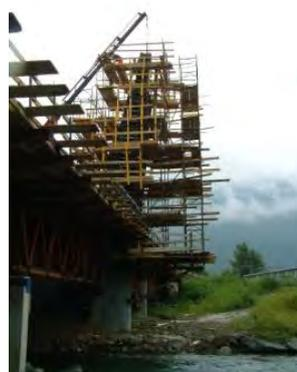
**Figura 424.** Ponteggio su mensole di rampata HSB per pulvino
