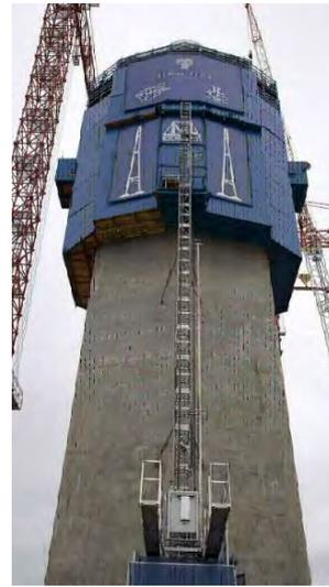
Figura 258. Esempio di sistema autorampante SCF
