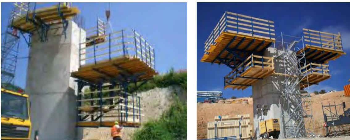
**Figura 222.** Mensole di rampata HSB con sottoponte
