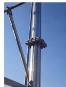
**Figura 308.** Esempio collegamento testa/testa
