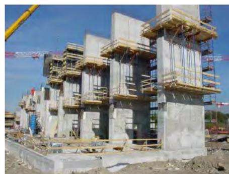
Figura 369. Sistema di rampata KK con sottoponti
