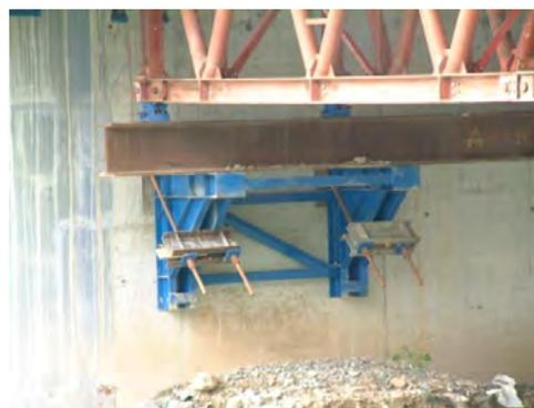
Figura 385. Mensola speciale di appoggio su pila centrale
