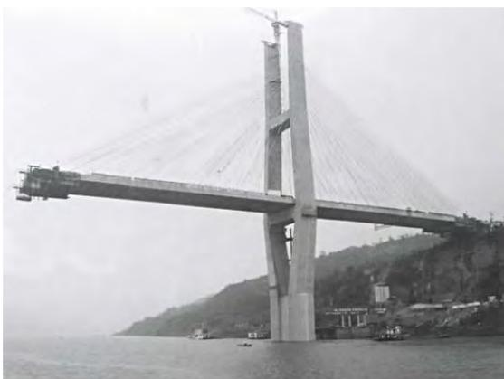
**Figura 142.** *Cassaforma mobile all'estremità di un impalcato in calcestruzzo gettato in opera*
