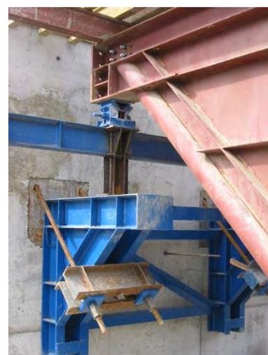
Figura 390. Martinetto vite-cuneo tra profilato d'appoggio e trave T50
