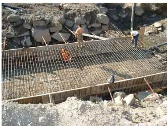
**Figura 348.** Plinto di fondazione gettato con cassero a telaio
