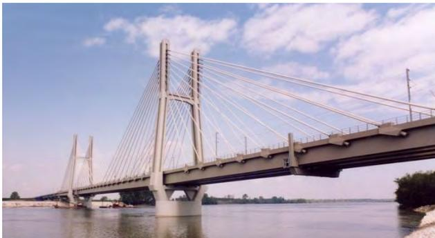
**Figura 81.** Ponte ferroviario TAV sul Po a Piacenza, con stralli a due piani verticali
