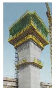
Figura 128. Esempio di cassaforma rampante
