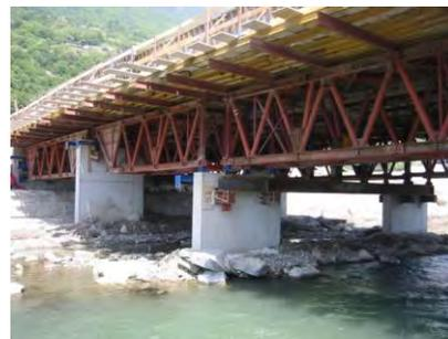
Figura 379. Travate reticolari di sostegno per getto impalcato (2/2)
