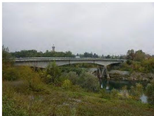
Figura 16. Impalcato a travata Gerber
