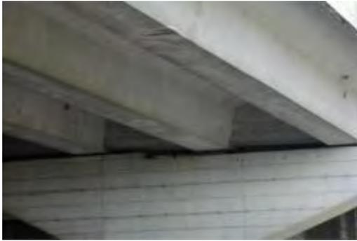
Figura 12. Traverso gettato in opera in un impalcato con travi prefabbricate in c.a.p.
