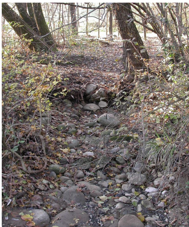
Figura n.16: Piccoli dislivelli dell'alveo già presenti prima del ripristino
