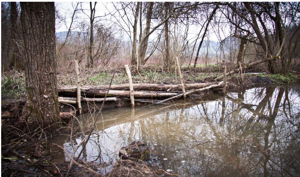
Figura n.18:Prime fasi di costruzione delle sponde;già sufficienti a trattenere l'acqua.
