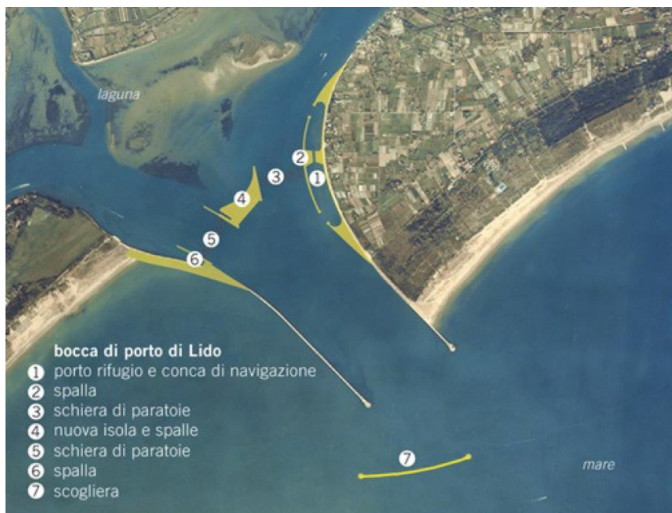
Figura 1.6 - Configurazione della bocca di porto di Lido a lavori ultimati
