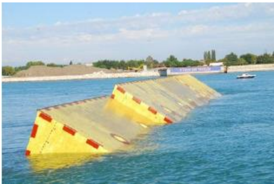
Figura 1.5 - Paratoie emerse durante la fase del collaudo
