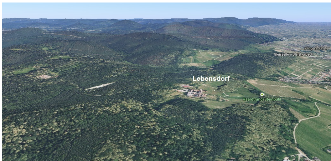
Figura 14: Veduta dall'alto del luogo in cui sorgerà Lebensdorf.
