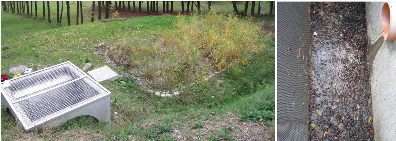
Figura 32 - La griglia in acciaio inox a monte del pozzetto di ingresso e la relativa opera di filtrazione.
