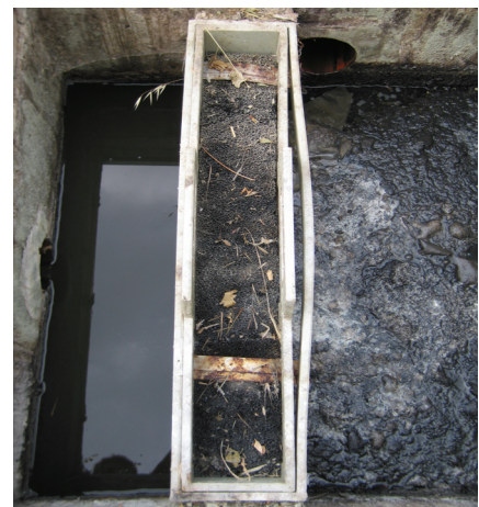
Figura 25 - Il filtro in Poliuretano montato all’interno di un pozzetto di ingresso e l’opera di filtrazione.
