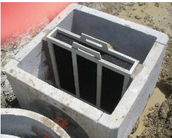
Figura 25 - Il filtro in Poliuretano montato all’interno di un pozzetto di ingresso e l’opera di filtrazione.
