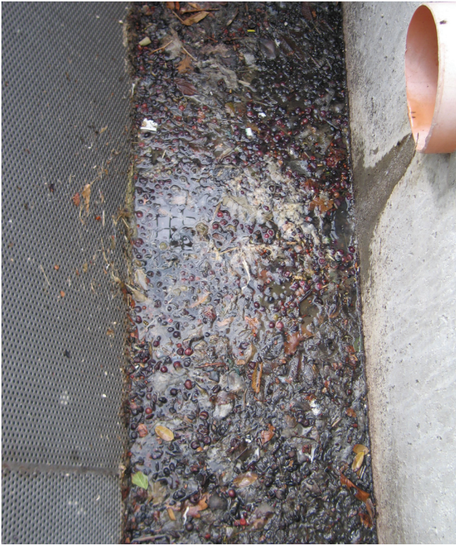
Figura 35 - I residui di lavorazione fermati dalla griglia a monte dell'impianto (a sinistra) e il refluo nel pozzetto d'ingresso, prima del filtro in poliuretano (a destra)
