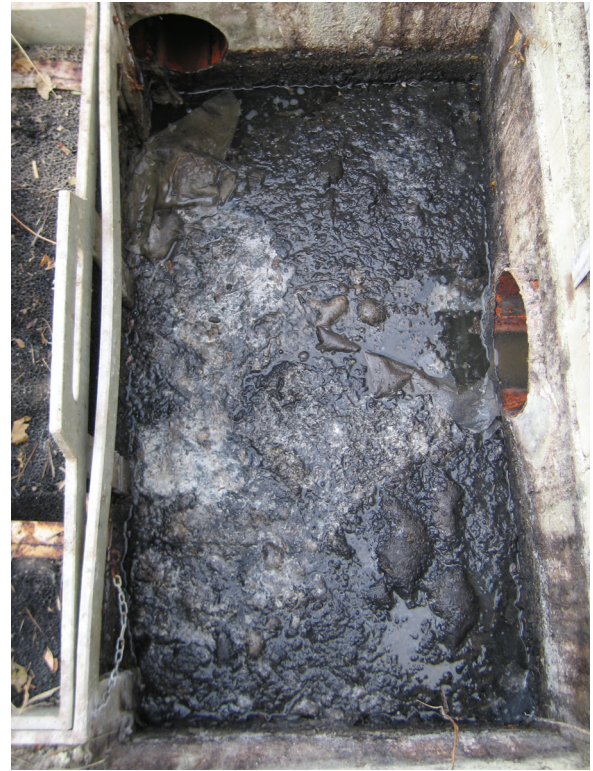
Figura 35 - I residui di lavorazione fermati dalla griglia a monte dell'impianto (a sinistra) e il refluo nel pozzetto d'ingresso, prima del filtro in poliuretano (a destra)
