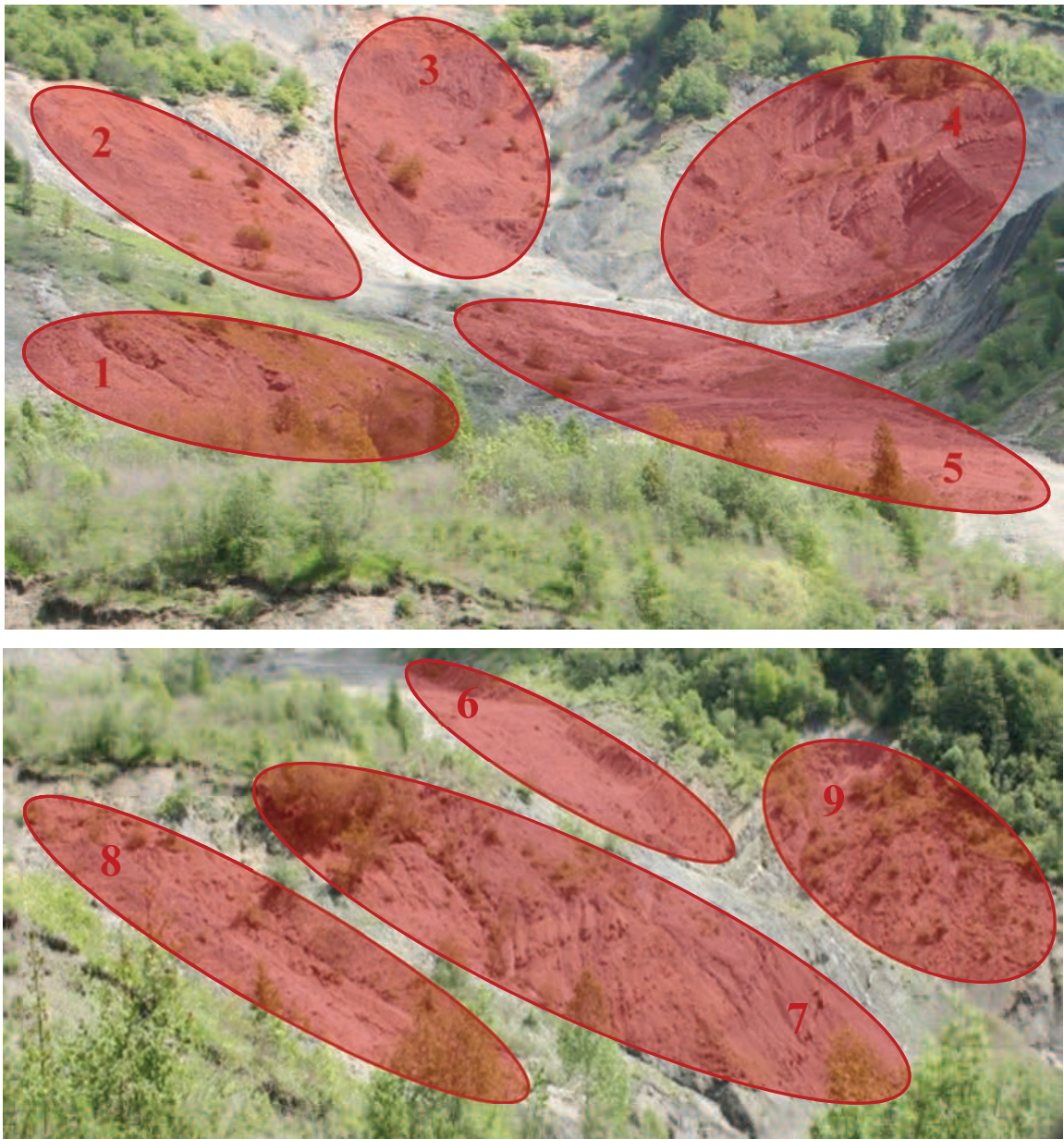
Figura 3.6: Zonizzazione delle due parti del corpo di frana in una fotografia scattata dalla fotocamera di sinistra (posta sopra il pilastro)
