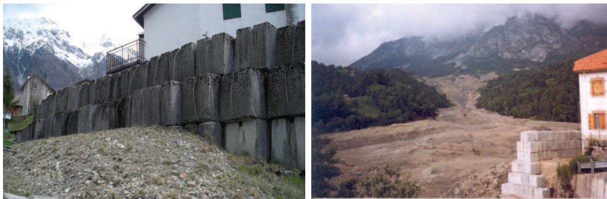
Figura 1.11: Muro in blocchi in calcestruzzo eretto in prossimità dell'abitato di Funes nel 1992
