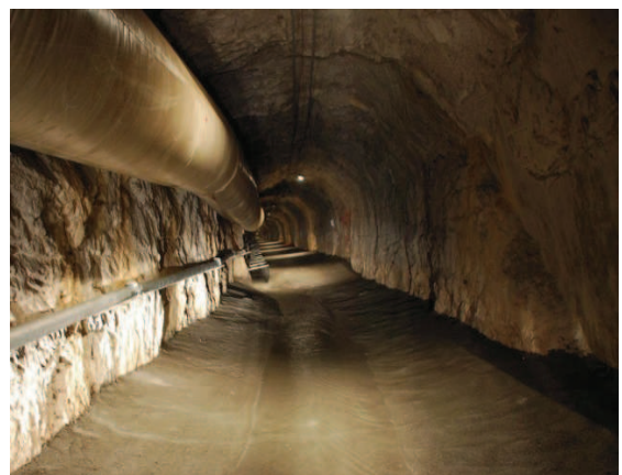
Figura 1.12: Inquadramento della galleria drenante ( Genio Civile di Belluno ) e foto del suo interno ( www.iqtconsulting.it )
