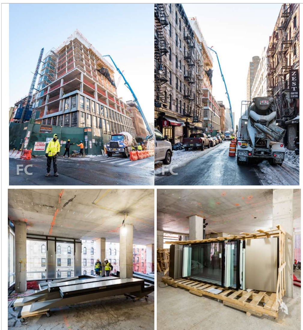
Fig. 3.21 – Serie di immagini reali di un cantiere a New York. Gli spazi esterni ed interni sono estremamente ridotti.
