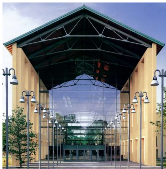
Fig. 3.11 – Auditorium Paganini (PR) con facciata a montanti e traversi.
