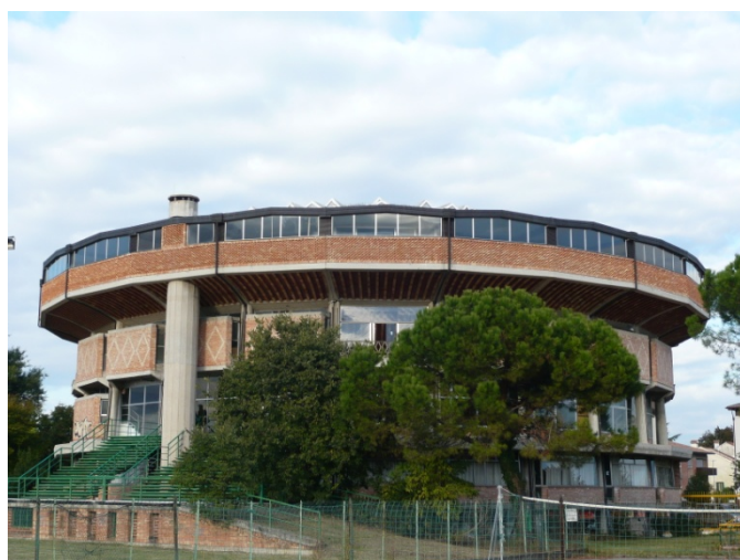
Figura 37: lato sud-ovest con scalinata
