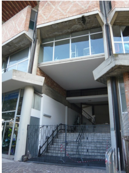
Figura 38: porzioni di solaio non previste
