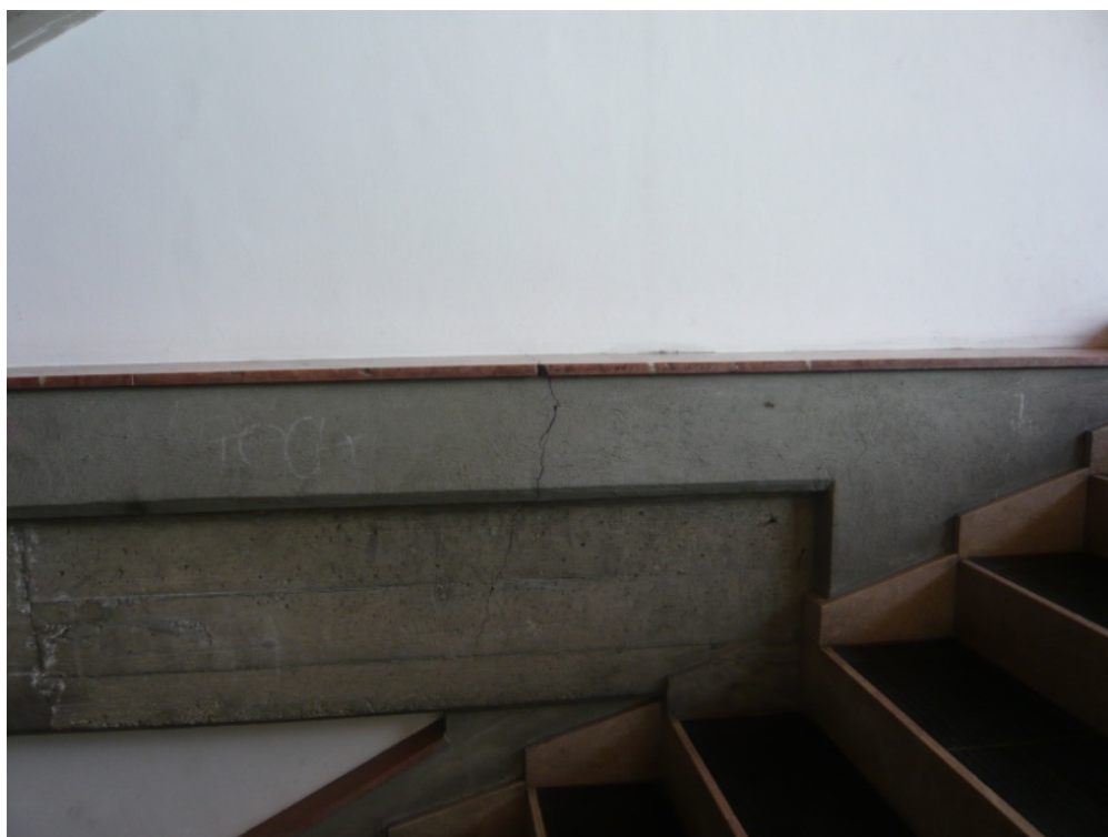
Figura 45: fessurazione calcestruzzo
