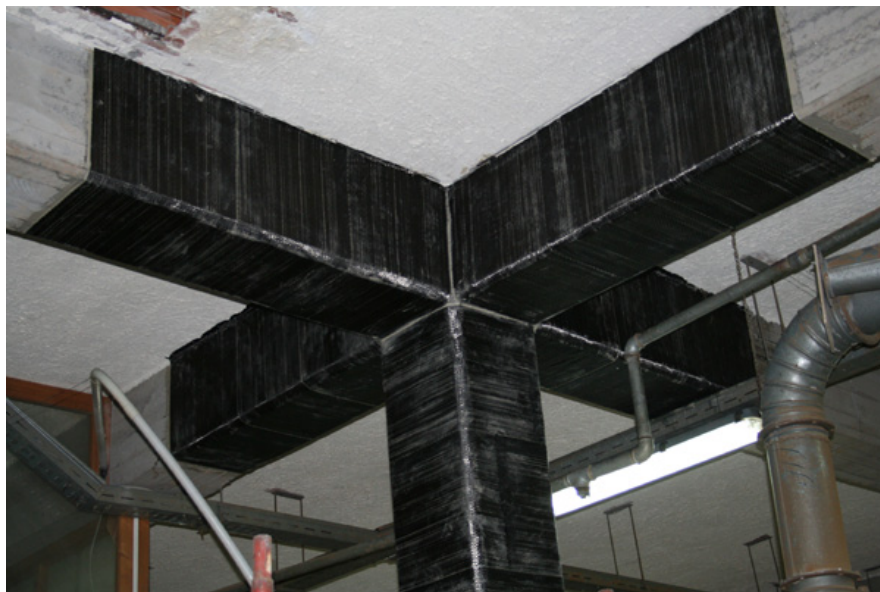
Figura 66: rinforzo di un nodo trave-colonna con applicazione di CFRP
