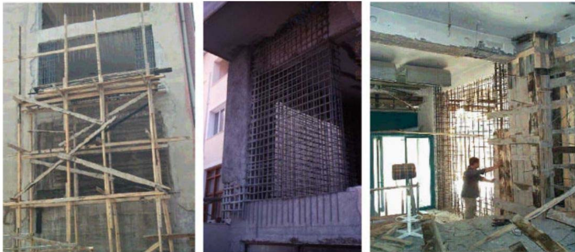
Figura 64: costruzione di parete all'interno della maglia strutturale (G.E. Thermoul and A.S.Elnashai – 2005)
