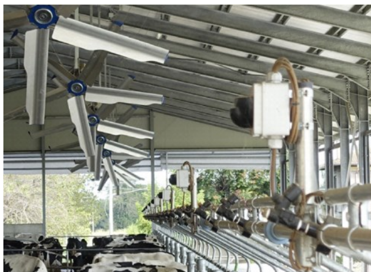
Figura 4.2: Ventilazione in corsia di alimentazione con ventilatori LVHS e sensori rileva presenza (“Un alleato contro lo stress da caldo – Coolibri,” n.d.).
