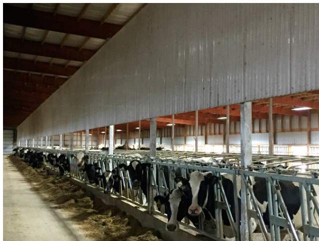
Figura 3.3: deflettori installati in una stalla a ventilazione trasversale (Mondaca, 2019).
