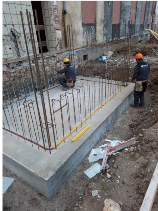
Figura 128 - Platea in c.a. del locale tecnico
