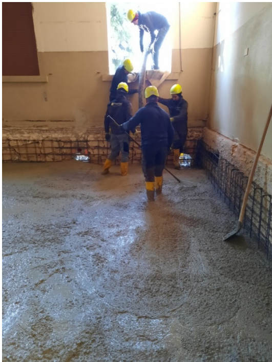
Figura 109 - Livellamento della platea di fondazione
