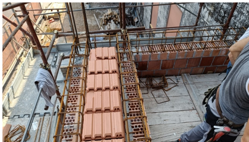
Figura 130 - Ferri di armatura per cordolo in c.a. al primo piano - Vano tecnico
