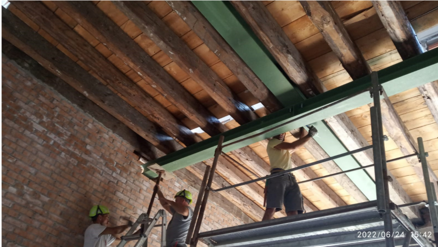
Figura 121 - Fissaggio della trave HEB 200 alla trave HEB 220 sovrastante - Piano Primo
