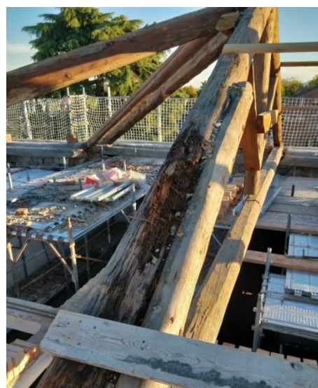
Figura 74 - Stato di marcescenza di una porzione di capriata - Copertura
