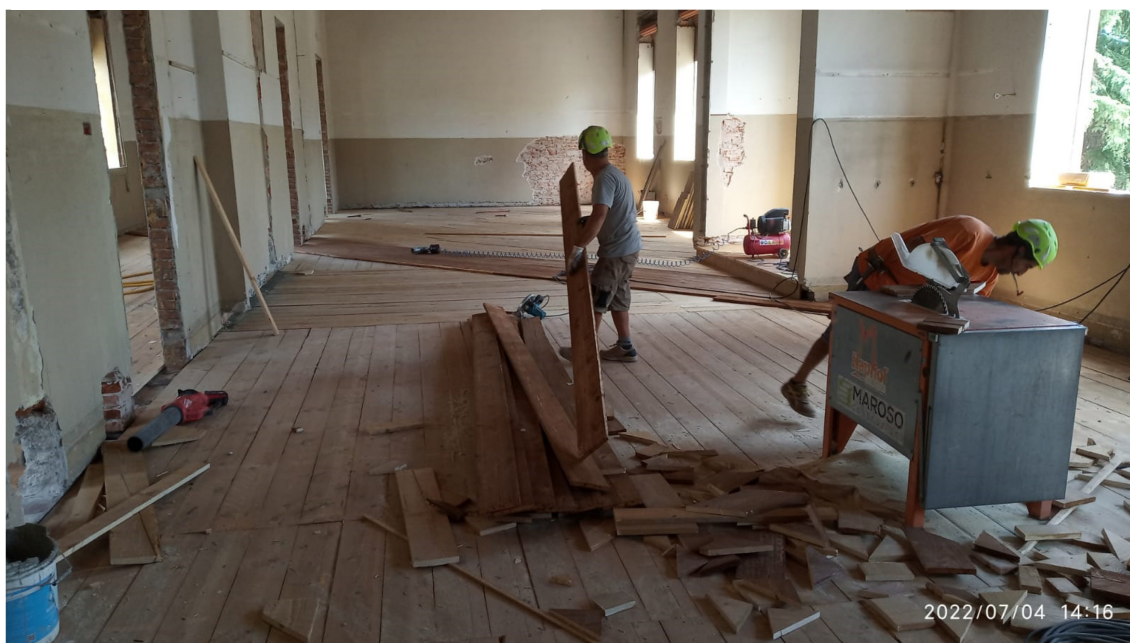
Figura 125 - Posa di doppio tavolato in legno incrociato - Piano primo
