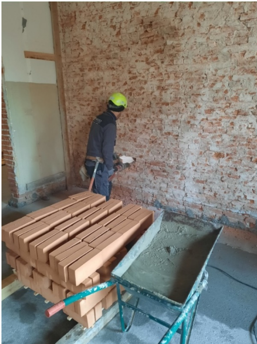
Figura 117 - Scasso di mattoni pieni per l'intervento di consolidamento delle murature
