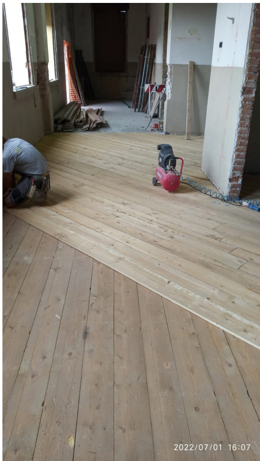
Figura 123 - Doppio tavolato incrociato nel corridoio lato Nord - Piano Primo
