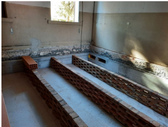
Figura 112 - Riposizionamento dei muricci in laterizio precedentemente rimossi
