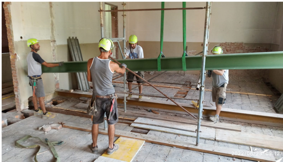
Figura 120 - Posizionamento delle travi HEB200 nel solaio in legno - Piano primo
