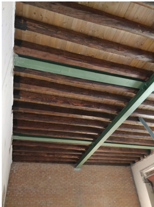
Figura 122 - Consolidamento del solaio in legno - Piano primo
