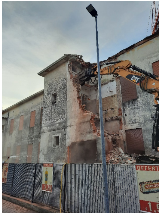
Figura 127 - Demolizione dei vani esterni - Stato di fatto
