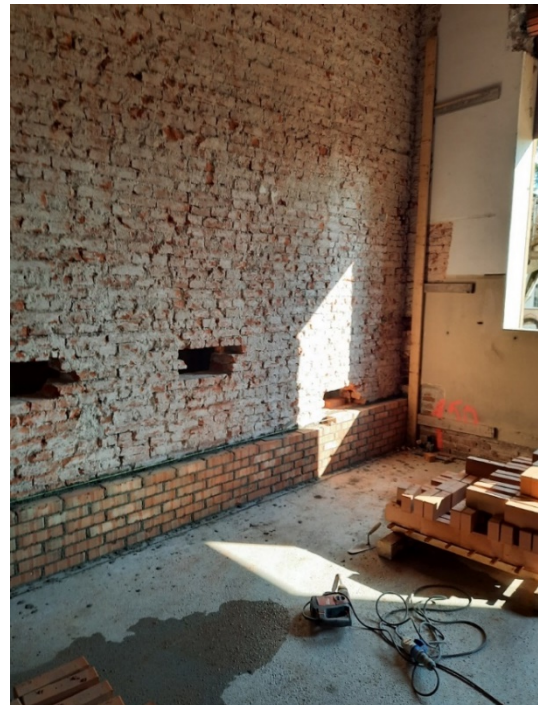
Figura 118 - Consolidamento delle murature - Piano terra
