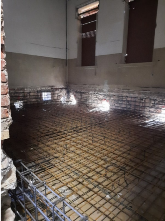
Figura 107 - Posa di armature e maglie elettrosaldate nella platea di fondazione
