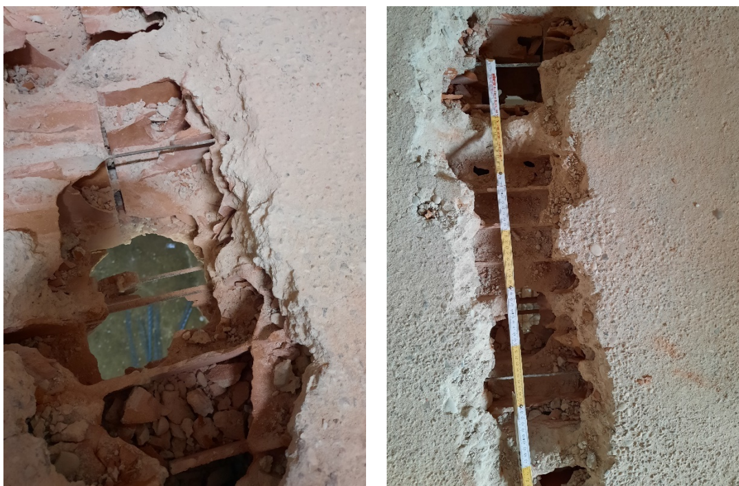
Figura 55 - Sondaggio solai in latero-cemento -Piano Primo
