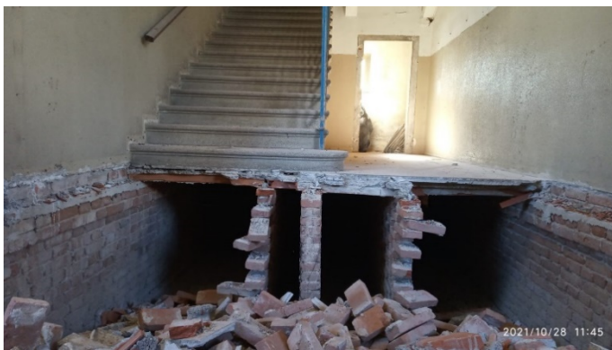
Figura 102 - Demolizione dell'impalcato e rimozione dei muricci – Piano terra
