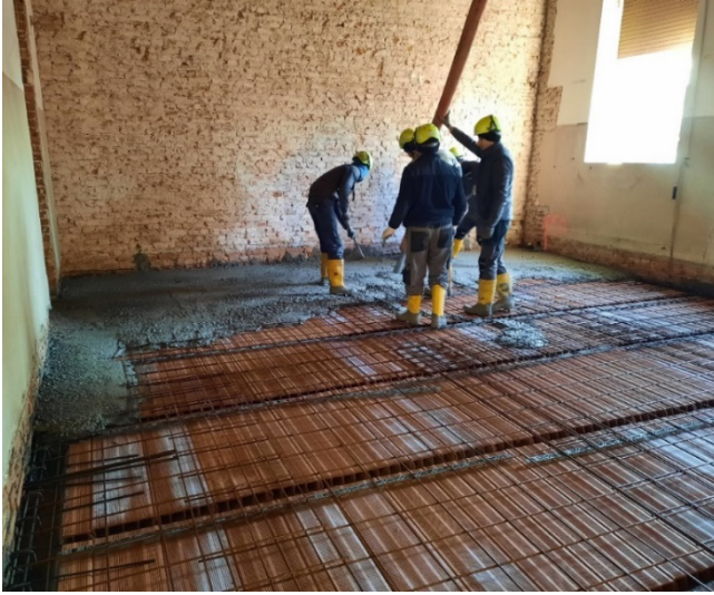
Figura 116 - Getto della cappa in calcestruzzo sopra tavellonato in laterizio - Piano terra
