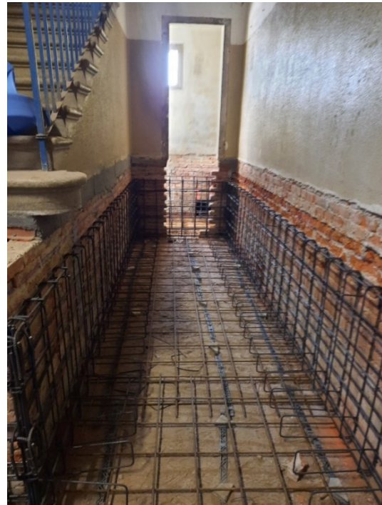
Figura 104 - Ferri d'armatura nel corridoio vano scale
