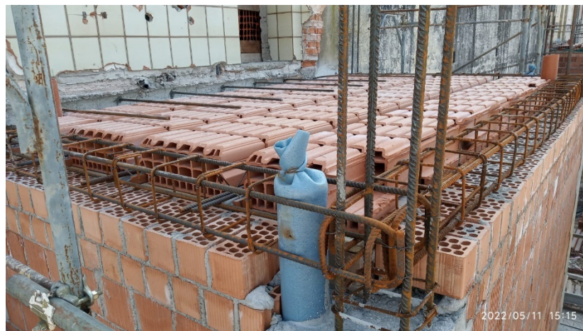
Figura 129 - Solaio in latero-cemento su muratura in mattoni forati - Vano tecnico
