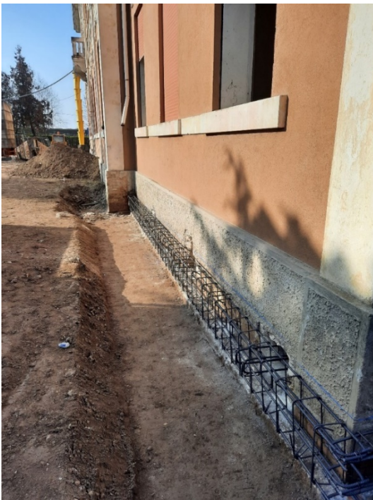
Figura 105 - Ferri d'armatura per il rinforzo della fondazione esistente
