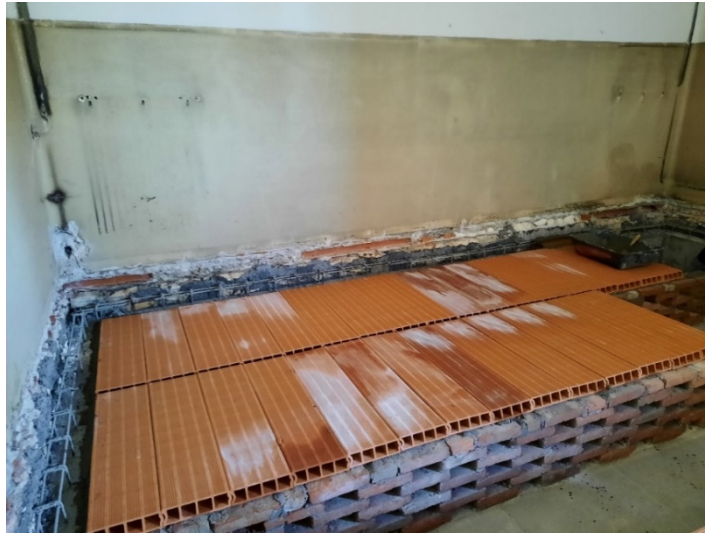
Figura 111 - Posa di tavellonato in laterizio - Piano terra
