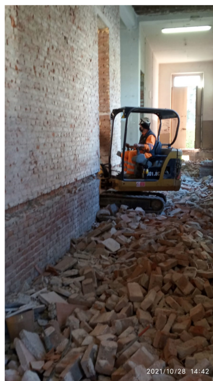
Figura 103 - Demolizione dei muricci di fondazione con mini-escavatore – Piano terra
