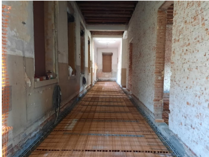
Figura 114 - Solaio in tavellonato nel corridoio lato Nord
