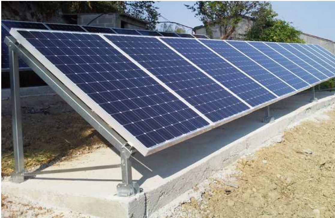
Figura 7.1: struttura a cavalletto con piano dei moduli fisso.
