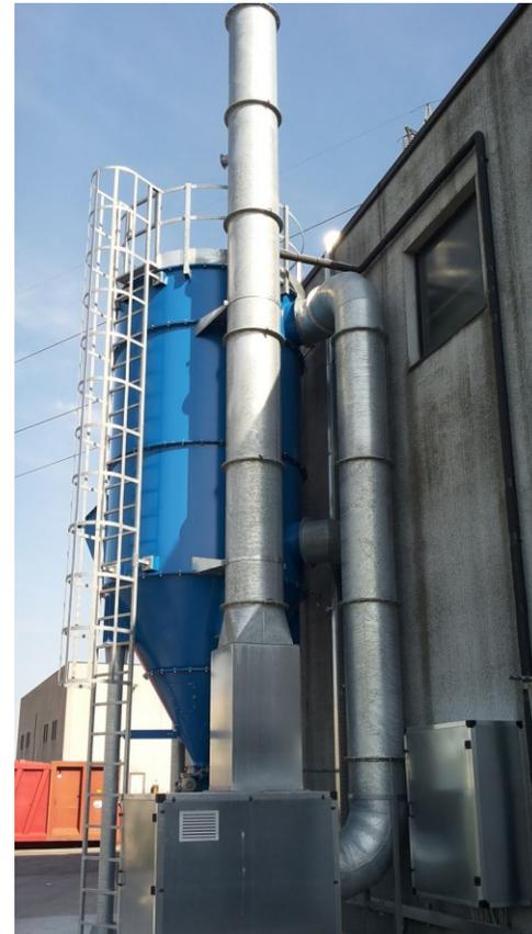
La filtrazione avviene grazie alle forze centrifughe. Questo impianto è l'ideale per la rimozione di polveri grossolane con elevato peso specifico e come prefiltro per impianti con maggiore capacità di filtrazione. Esistono due configurazioni differenti per il ciclone: quello ad alta efficienza e quello ad alte portate.
