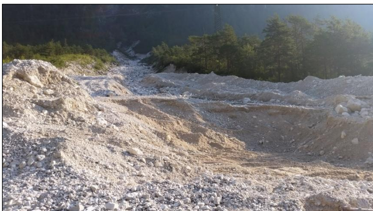
Figura 49: Dell'evento di agosto lungo il Giau di Gravon Piccolo si dispone solo di foto a lavori di ripristino già iniziati.
