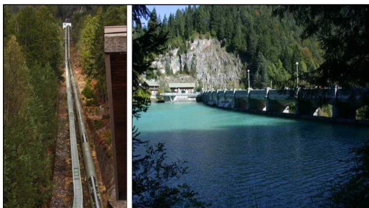
Figura 4: A sinistra il condotto della centrale elettrica di Somprade. A destra la diga di Auronzo. Questa è causa della formazione del lago omonimo, con una
