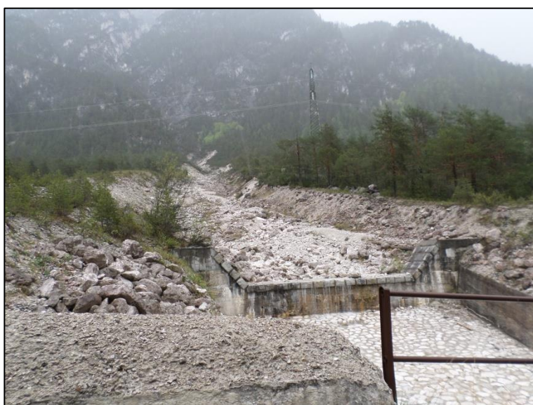
Figura 17: Giau di Gravon Piccolo, è uno dei torrenti affluenti al Marzon. Si tratta di un corso d'acqua dalla grande capacità erosiva che frequentemente dà luogo a debris flow.
