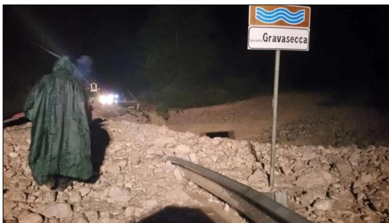
Figura 18: Colata detritica su torrente Gravasecca invade la strada regionale e sradica i cavi della linea interrata. Sono stati stimati 100000 m 3 di detrito e
