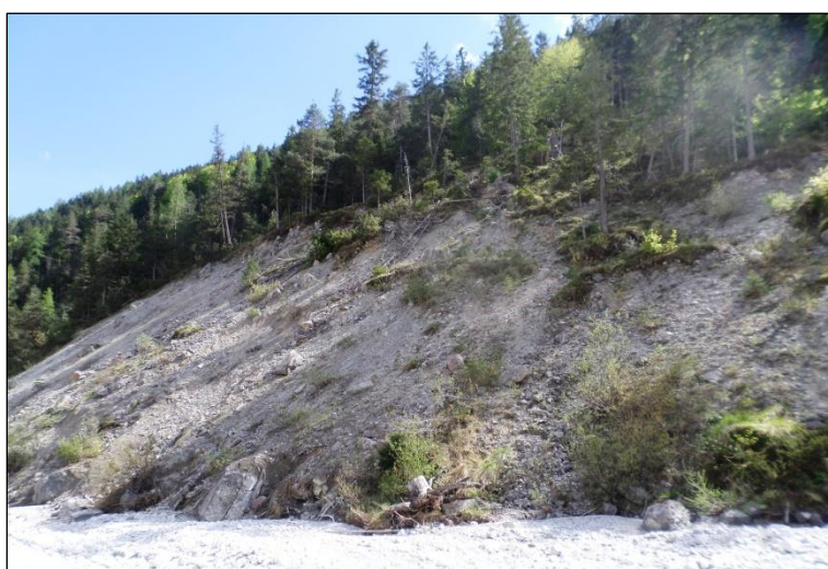
Figura 15a: Il versante è molto instabile e sembra in regressione. I detriti crollano direttamente nell'alveo di piena del fiume Ansiei.
