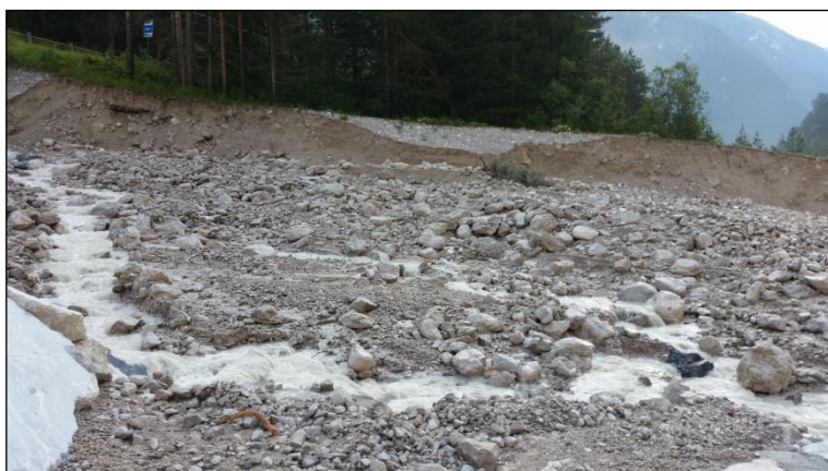
Figura 42: Particolare dell'erosione delle sponde sinistra del Gravasecca.
