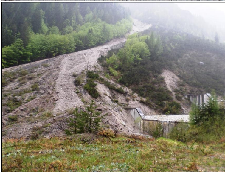
Figura 13b: Altro canalone di colata detritica nel versante destro della Val Marzon. Il deposito ha raggiunto il torrente Marzon, ricoprendo in parte le briglie. Questa situazione aumenta la
