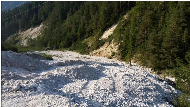
Figura 50: Il deposito del debris flow del 4 agosto ha invaso l'alveo del Marzon
