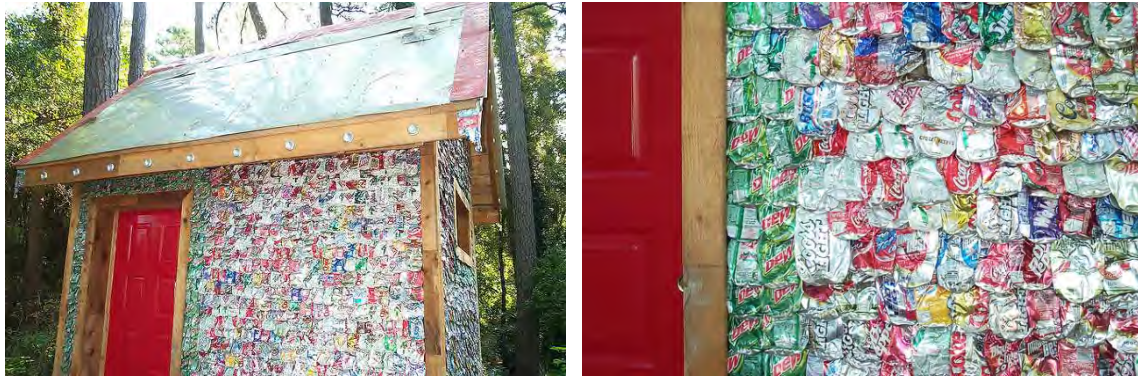
Fig. 24. Plant Environment: la struttura principale è in legno e il rivestimento è costituito da lattine.
