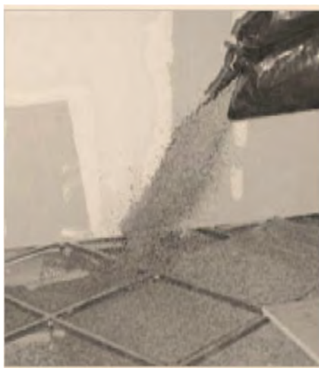
Fig. 20. Applicazione di sughero granulato come isolamento del solaio.
