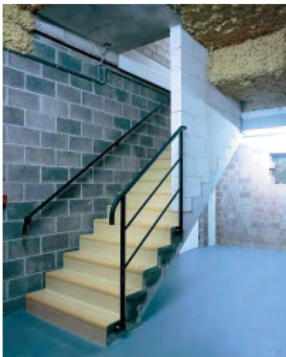
Fig. 11. Vista della cantina: scala in cemento riciclato con rivestimento dello strato inferiore in PVC riciclato; parete (a sinistra) in blocchi d cemento con scorie di acciaio, parete di fondo in blocchi di terracotta. La pavimentazione è costituita da plastica riciclata e sul soffitto si trova dell'isolamento spray in lana di vetro riciclata. Fonte: www.recyhouse.be
