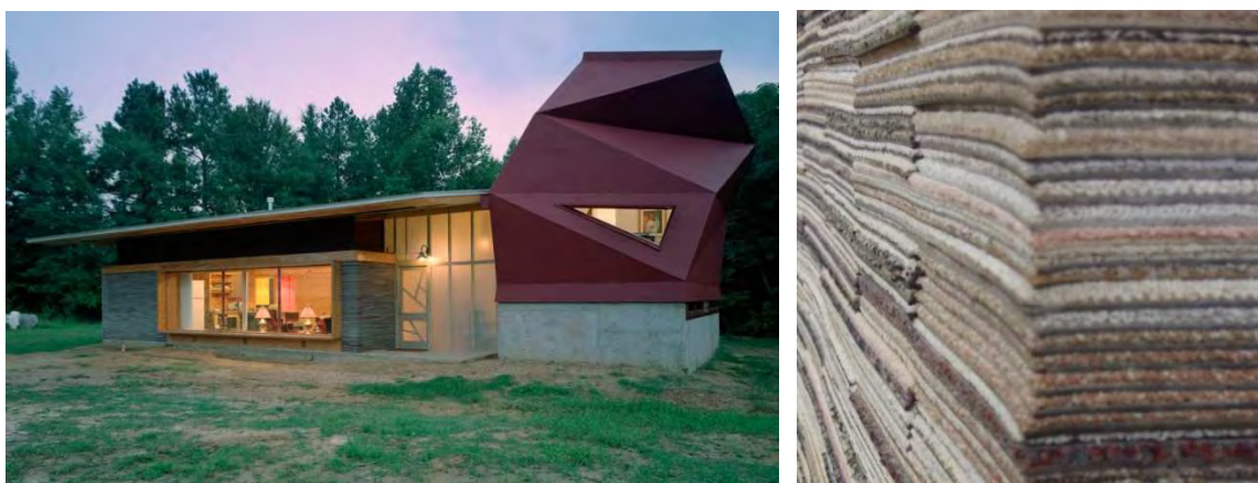
Fig. 26. Lucy Carpet House, 2002: le pareti perimetrali esterne sono costituite da strati di tappezzeria sovrapposti e tenuti in compressione da una grossa trave in legno. Fonte: www.ruralstudio.org
