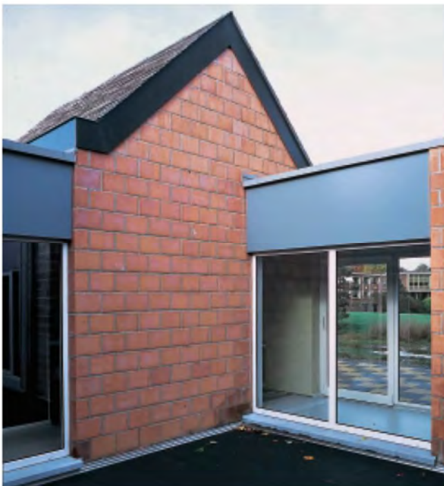
Fig. 8. Vista del patio di connessione tra l'edificio principale e gli annessi. Si trova una pavimentazione drenante in lastre di gomma riciclata, pareti perimetrali esterne con blocchi di terracotta e polistirolo espanso di scarto, copertura rivestita in plastica riciclata.
