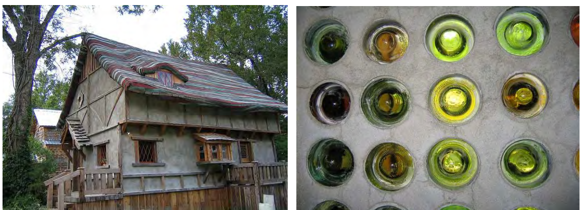
Fig. 23. Story Book House: nella foto si nota un dettaglio di come, attraverso delle bottiglie di vetro inserite in un getto di calcestruzzo, viene portata la luce all'interno dell'abitazione in alcuni punti.
