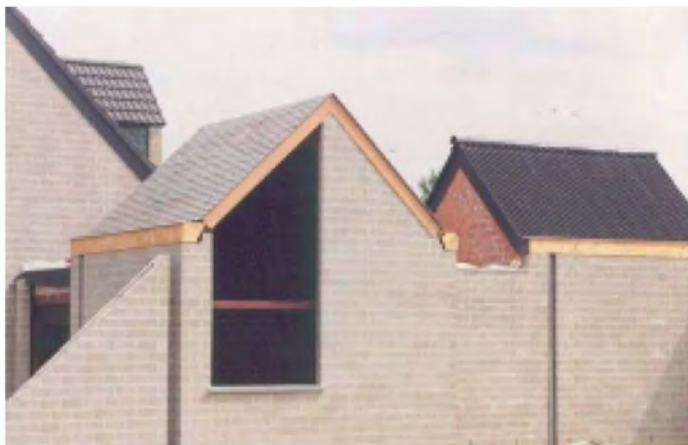
Fig. 10. Vista degli edifici annessi in costruzione: a sinistra si nota una copertura con plastica riciclata, mentre a destra con giornali saturati con bitume.
