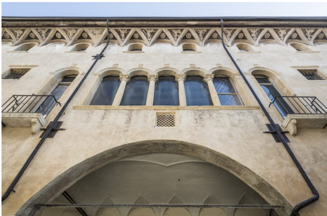
Figura 2.4 – Complesso Roccabonella – Facciata principale
