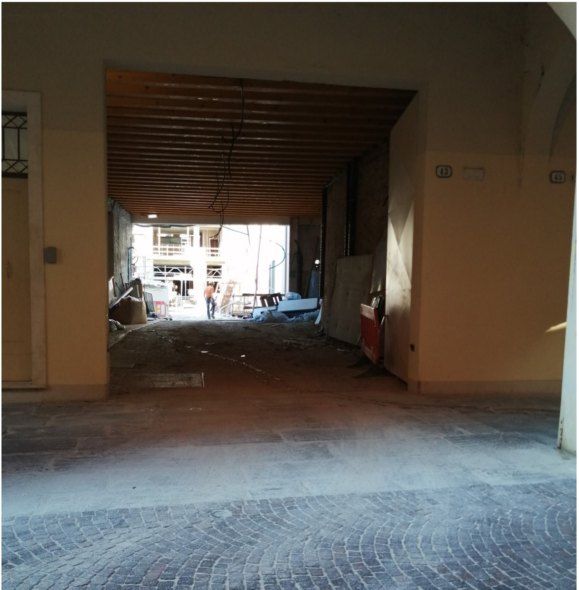
Figura 4.10 – Ingresso del cantiere da Via San Francesco
