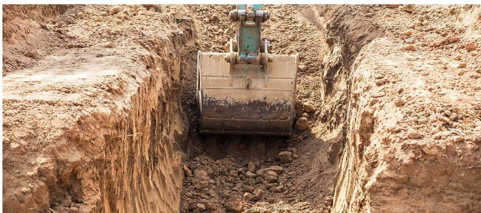
*Figura 13. Esecuzione dello scavo per la realizzazione della trincea drenante*
