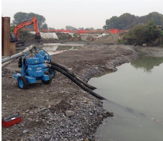
Figura 2. Pompe di aggotamento in esecuzione
