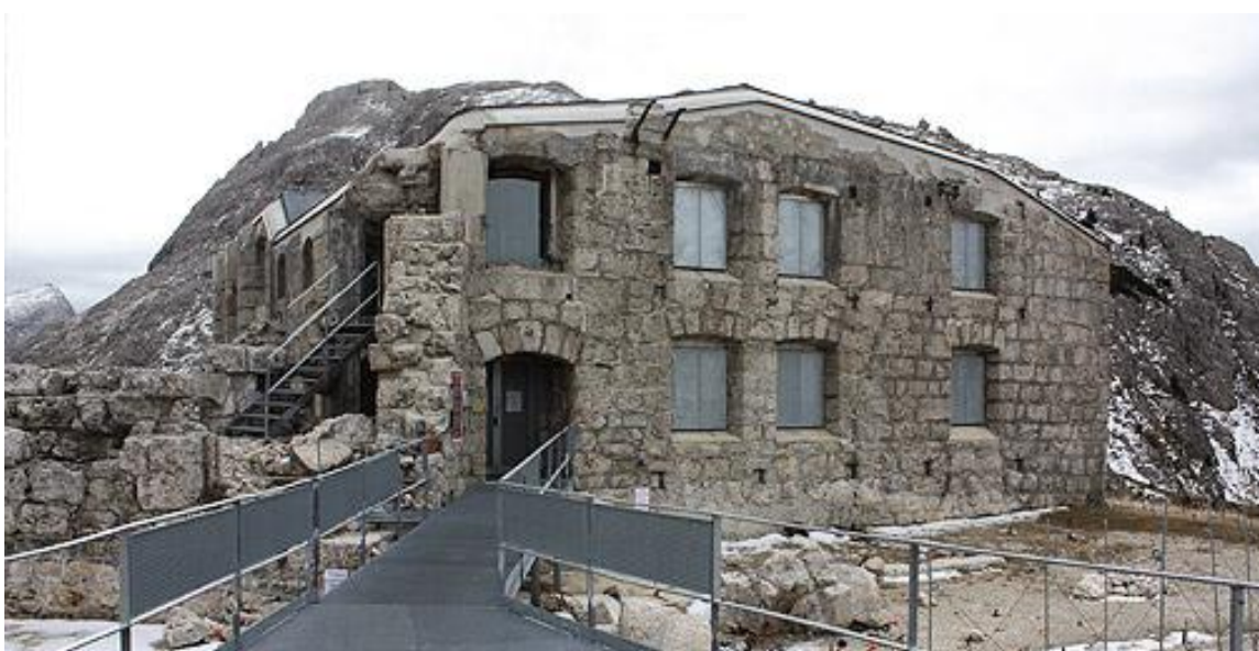
Figura 1.20 Forte Tre Sassi (inizio XX secolo) ora Eco Museo della Grande Guerra dopo l'intervento di restauro.
