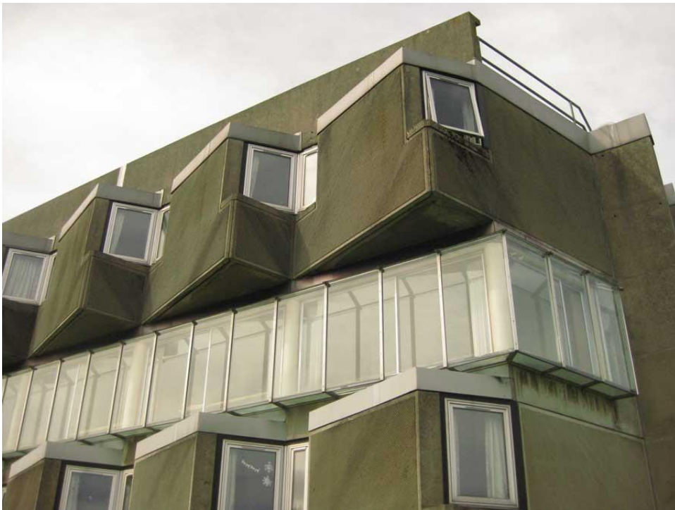
Figura 6.4 Vista della fine di una delle strutture con in evidenza la strada di distribuzione
