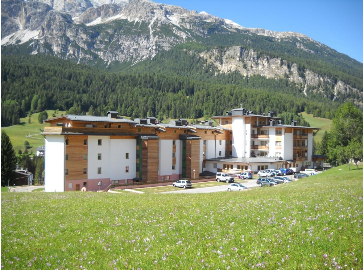
Figura 3.3 Preesistenza confinante con l'area di progetto in cui si mostra la via di accesso prescritta dal bando: l'immobile è una casa popolare risalente al 2005
