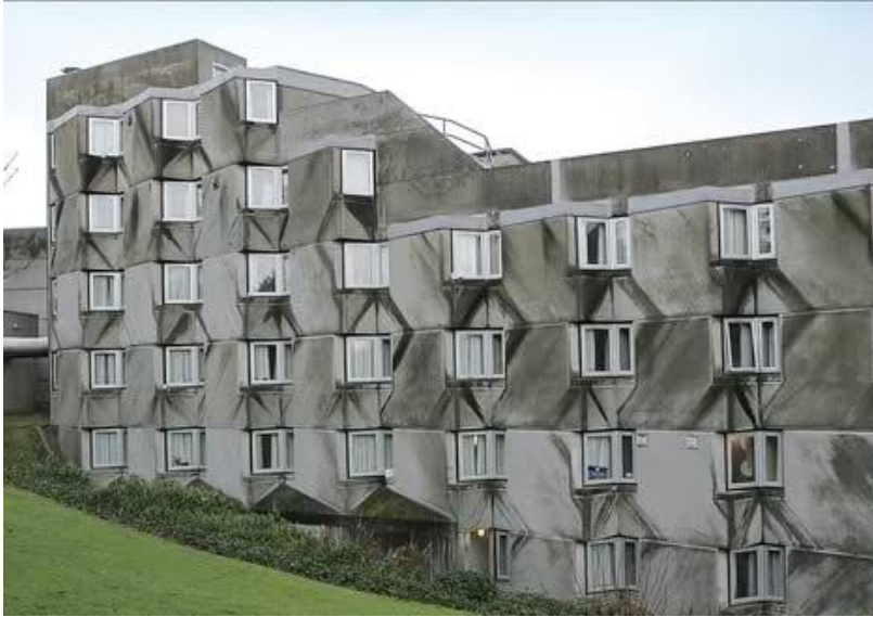
Figura 6.3 Dettaglio dell'inizio di uno dei corpi residenziali in cui si nota il digradare dell'altezza e le finestre inclinate per poter goder di una maggiore vista panoramica.
