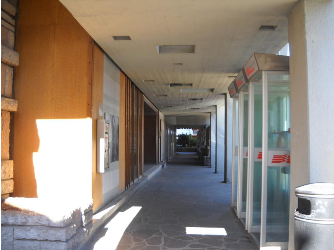
Figura 1.23 Particolare della galleria del palazzo delle Telve e delle Telecomunicazioni
