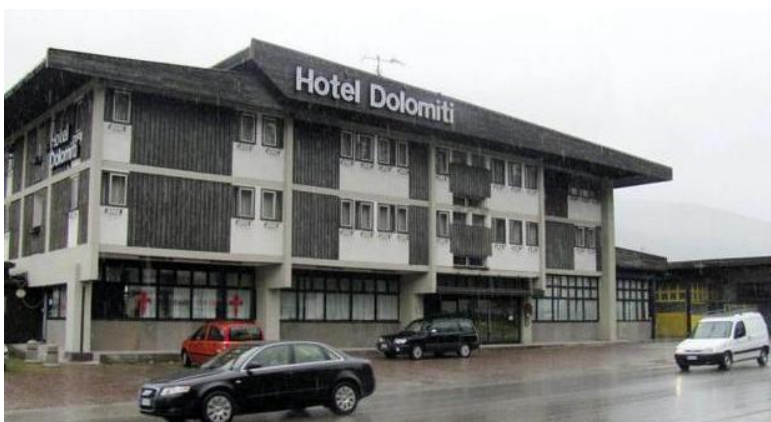
Figura 1.26 Stato attuale dell'edificio (anni duemila) si nota il cambio dei tamponamenti esterni.
