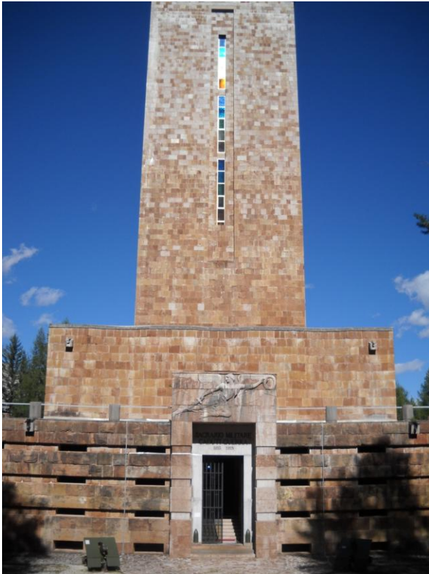
Figura 1.12 Particolare dell'ingresso al Sacrario con il basso rilievo della Nike alata.
