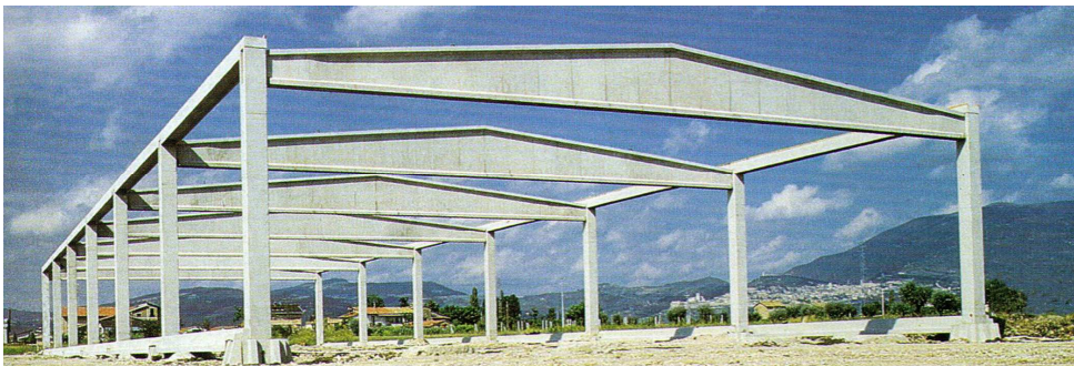
Figura 1.7: Esempio di costruzione a schema statico semipendolare per edilizia industriale
