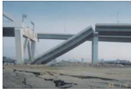
Figura1.1: Crollo parziale o totale di strutture in prefabbricato
