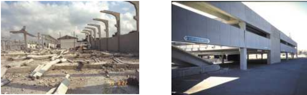
Figura 1.2: Collasso strutturale per effetto di perdita d'appoggio
