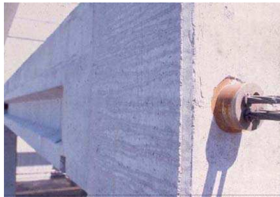
Figura 3.6: Vista della testata di una trave e schema del sistema di connessione – Soluzione progettuale n.2
