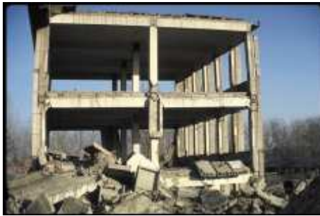
Figura1.1: Crollo parziale o totale di strutture in prefabbricato
