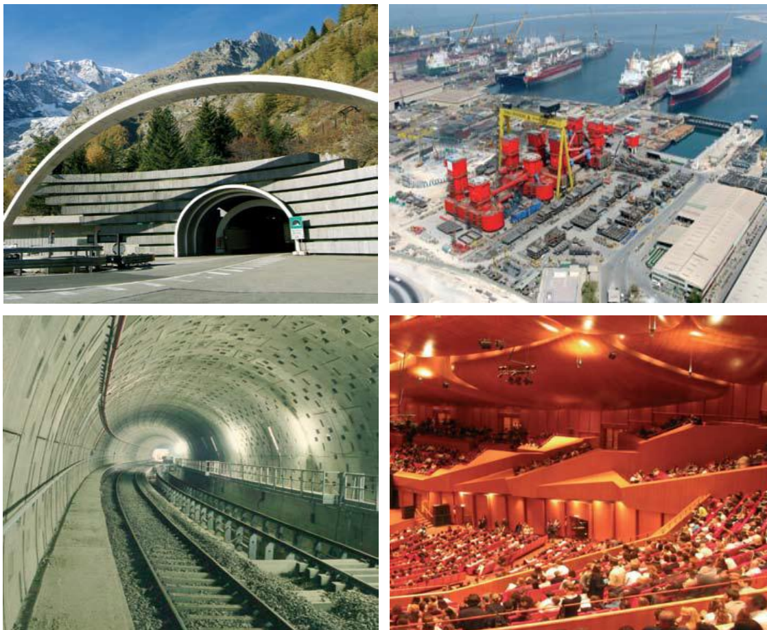
Figura 1.2 - Galleria del Monte bianco (in alto a sx), Cantiere Navale di Dubai (in alto a dx), Metropolitana (in basso a sx) e Auditorium (in basso a dx) di Roma;
